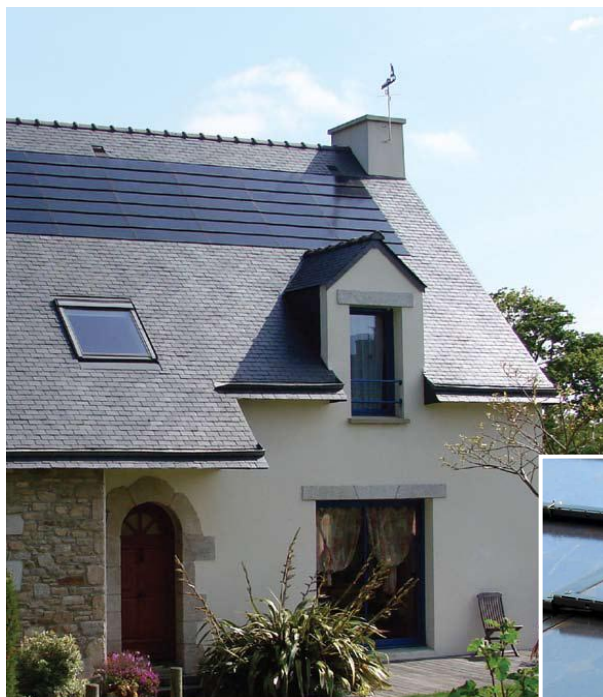
Figur 15 - SolarCenturies C21e solcellsskiffer baseras på högeffektiva solceller © Solarcentury.com
