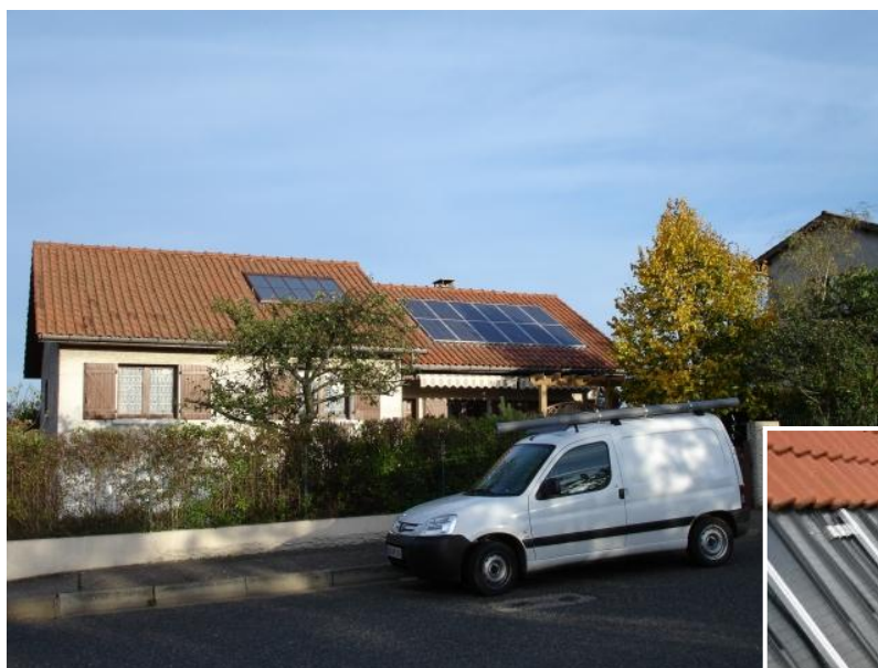
Figur 24 - Renusols Intersole system integrerad i ett tegeltak © Renusol
