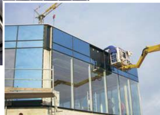
Figur 30 - Altec Solartechnik har utvecklat ett profilsystem optimerat för smidig montering. Det kan användas med standardmoduler, men även med marmor eller till glasfasader. ©Altec Solartechnik
