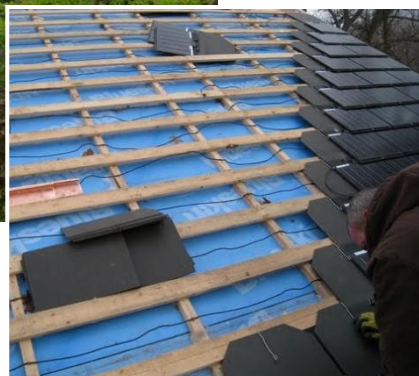
Figur 14 - Atlantis Energy Systems SunSlate består av en eternitskiva med solceller på © Atlantis Energy Systems
