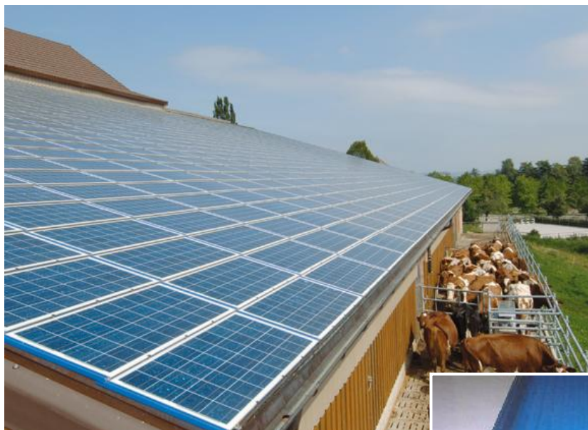
Figur 23 – Solrif-systemet (Ernst Schweizer) var bland de första takpaneliknande integreringslösningar. Specialram används på valfria moduler (se detalj) © Ernst Schweizer AG
