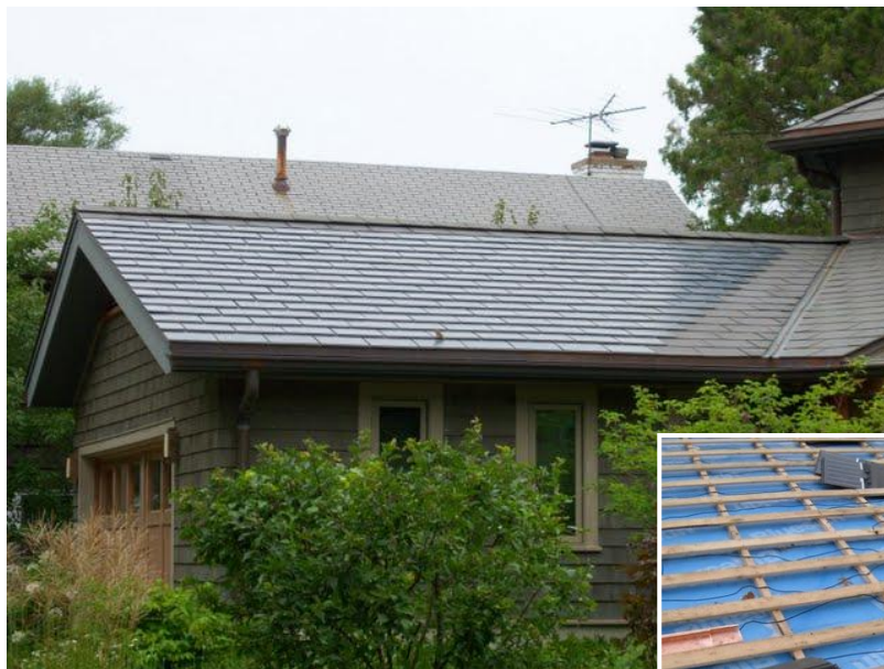
Figur 14 - Atlantis Energy Systems SunSlate består av en eternitskiva med solceller på © Atlantis Energy Systems
