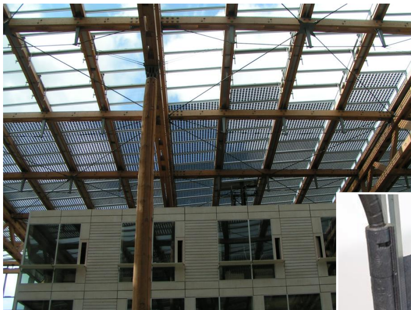
Figur 22 - På Akademie Mont-Cenis används kiselmoduler med olika täckningsgrad för att åstadkomma olika klimatzoner i byggnaden ©M van Noord (ovan) / Scheuten Solar (t.h.)
