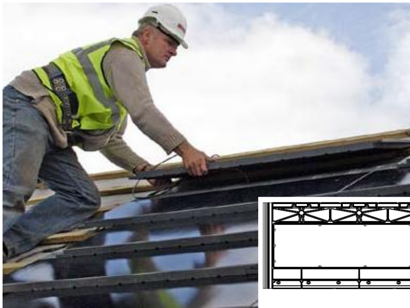
Figur 12 - SolarCenturies C21e tile använder Sunpower back-contact celler för ett uniformt svart utseende © Solarcentury.com
