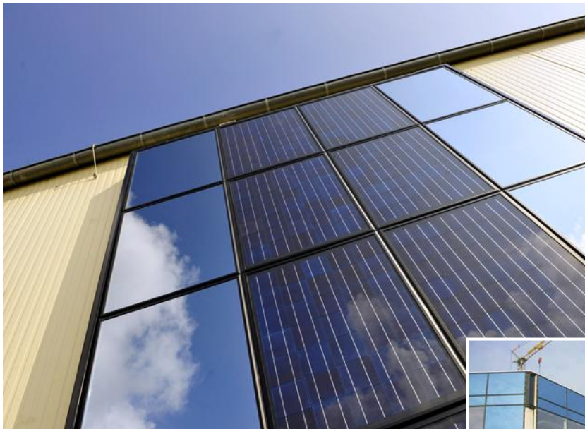
Figur 30 - Altec Solartechnik har utvecklat ett profilsystem optimerat för smidig montering. Det kan användas med standardmoduler, men även med marmor eller till glasfasader. ©Altec Solartechnik
