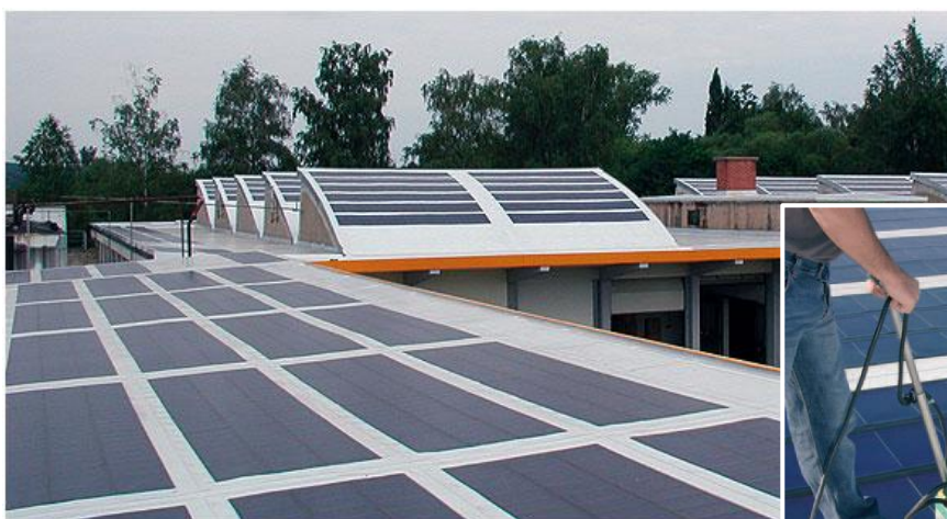
Figur 19 - Alwitrans produkt, Evalon Solar, använder UniSolars tunnfilmsmodul © Alwitra
