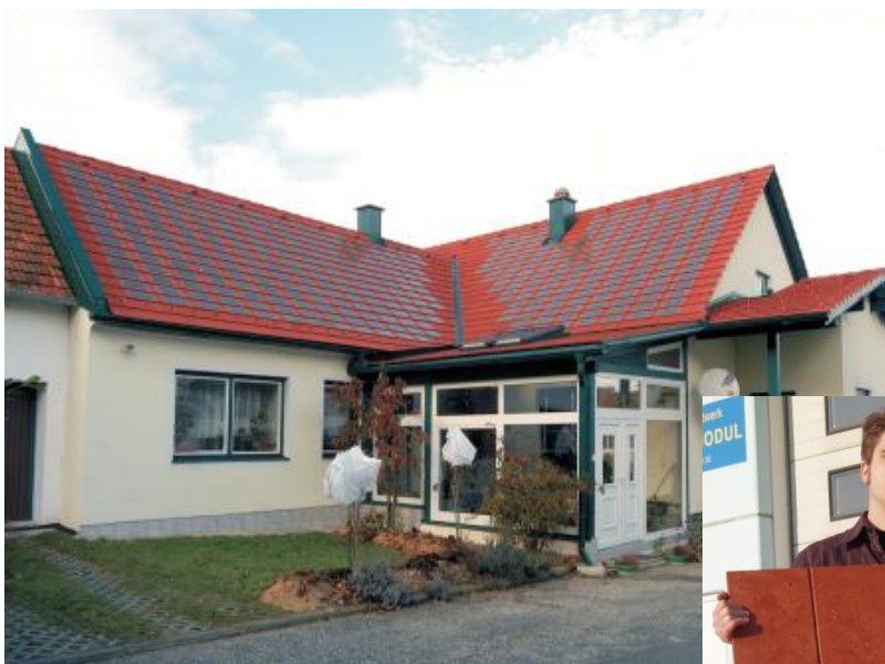
Figur 13 - SED:s solcellspanna kombinerar en blå solcellsyta med den klassiska orange färgen på återvunnen PVC-fri plast © SED
