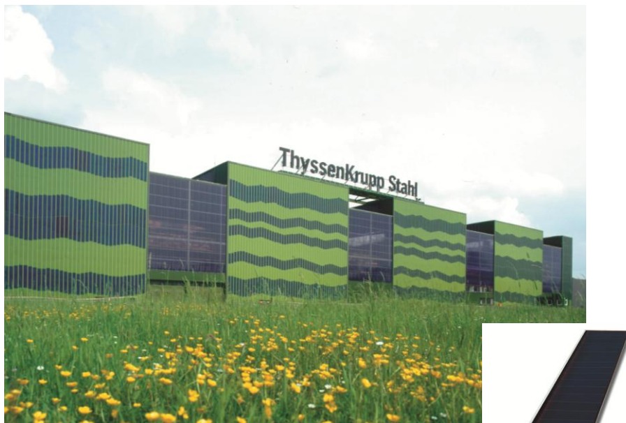
Figur 26 - ThyssenKrupps Solartec består av galvaniserad och plastcoatad stål med integrerad tunnfilmmodul © Thyssen-Krupp
