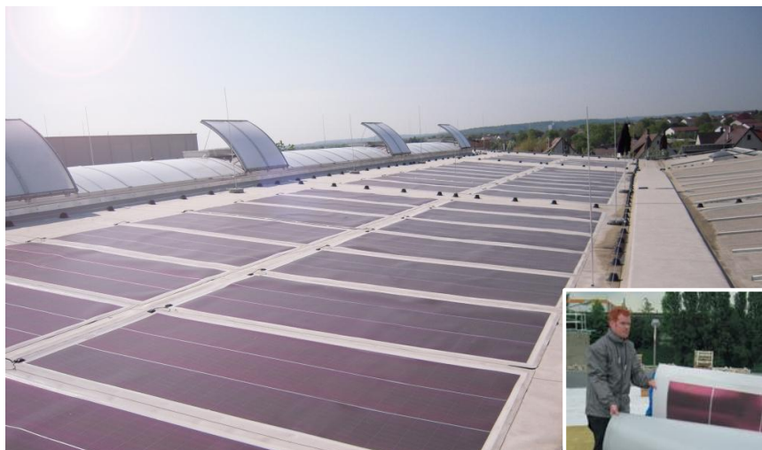
Figur 18 - Flexcells solcellsduk har anslutningen på ovansidan av produkten © Flexcell
