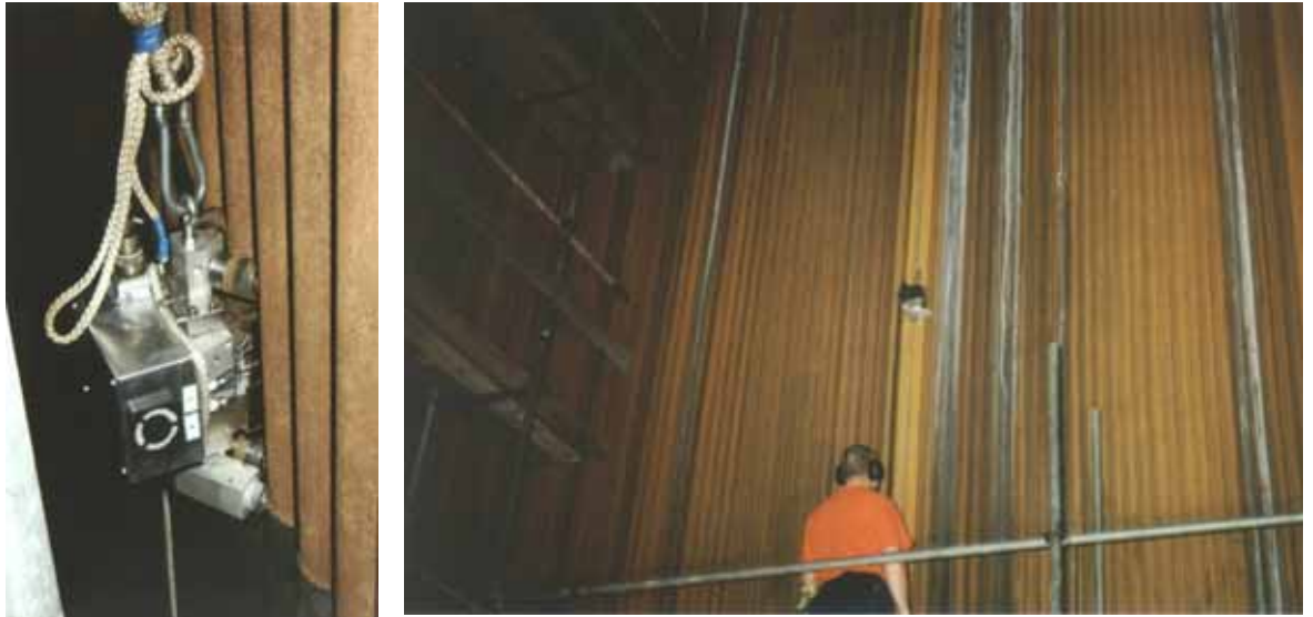
Figur 1.6-8 Utrustning, bestående av en vagn med ET prob som ligger an mot vägguben med hjälp av en kraftig magnet, för screening skanning av godstjocklek hos tuber i panelväggar. Till höger dras vagnen upp längs hela tublängden i en eldstad.
