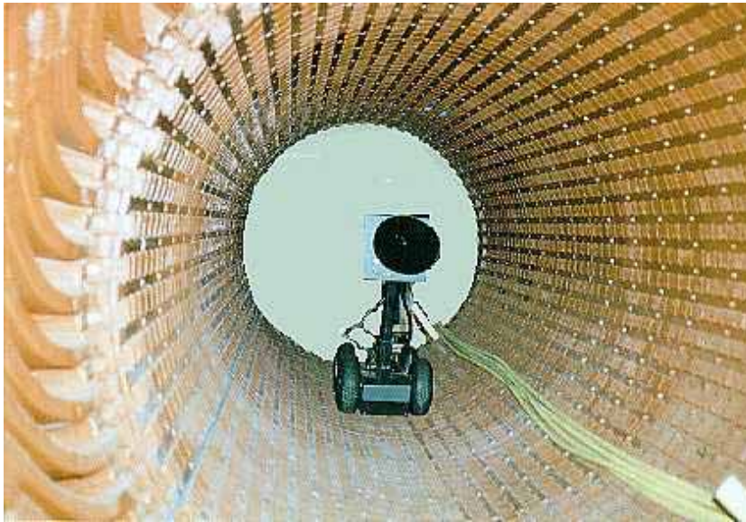
Figur 2.3.3-24. Plåtpaketsprov med termografisk kamera.
