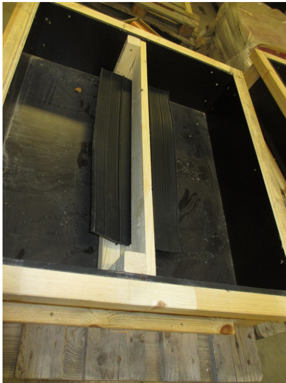
Fig. 3.13. Form för fogbandsprovkroppar. Fogbandet hölls på plats med en avskiljare i trä, vilken tillika användes som formsida för att erhålla en gjutfog.
