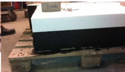
Fig. 3.4. Påbörjat montage av cellplast
