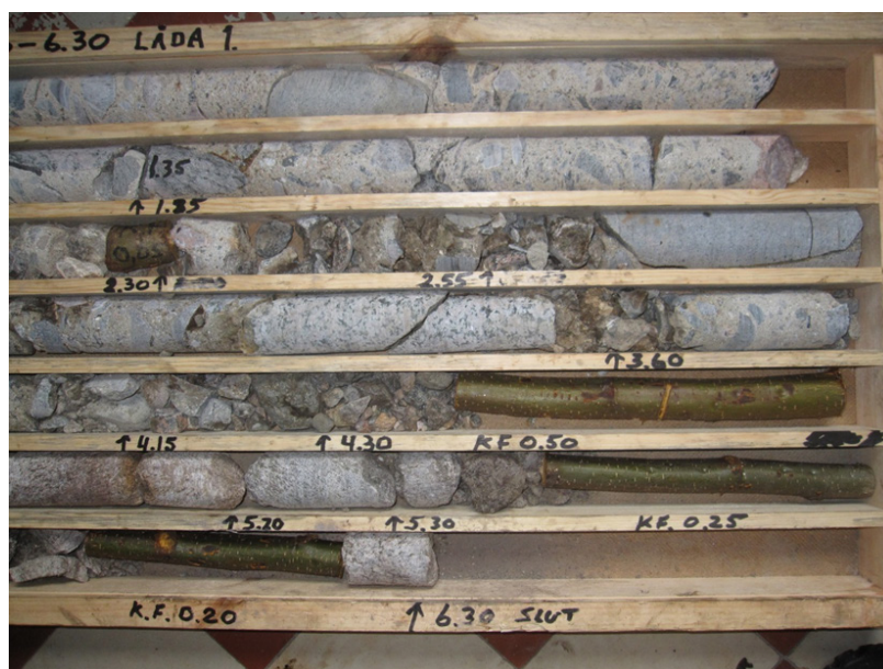
Figur 2-10 Borrkärnor från en urlakad betongdamm
