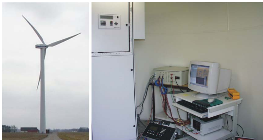
Figur 6.1 DFIG vindkraftverk på 850 kW och mät dator för fältmätningar.
