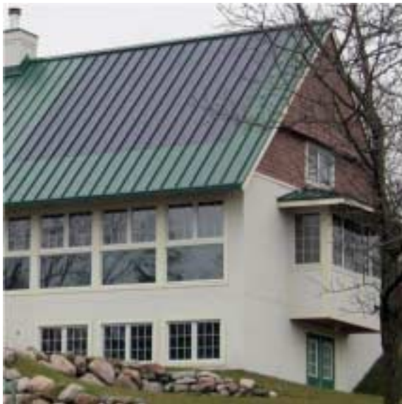
Figur 10: Nästan ”osynliga” takpannor i amorft kisel från Unisolar.
