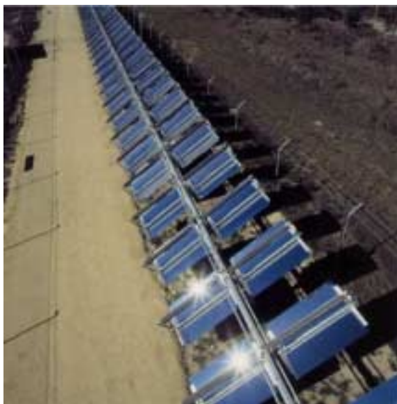
Figur 1: 20 kW p 25x demonstrationssystem i Rockingham, Australien.
