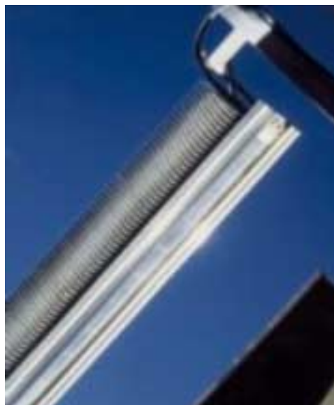
Figur 2: Närbild av de luftkylda solcellerna i det koncentrerande systemet i Rockingham.
