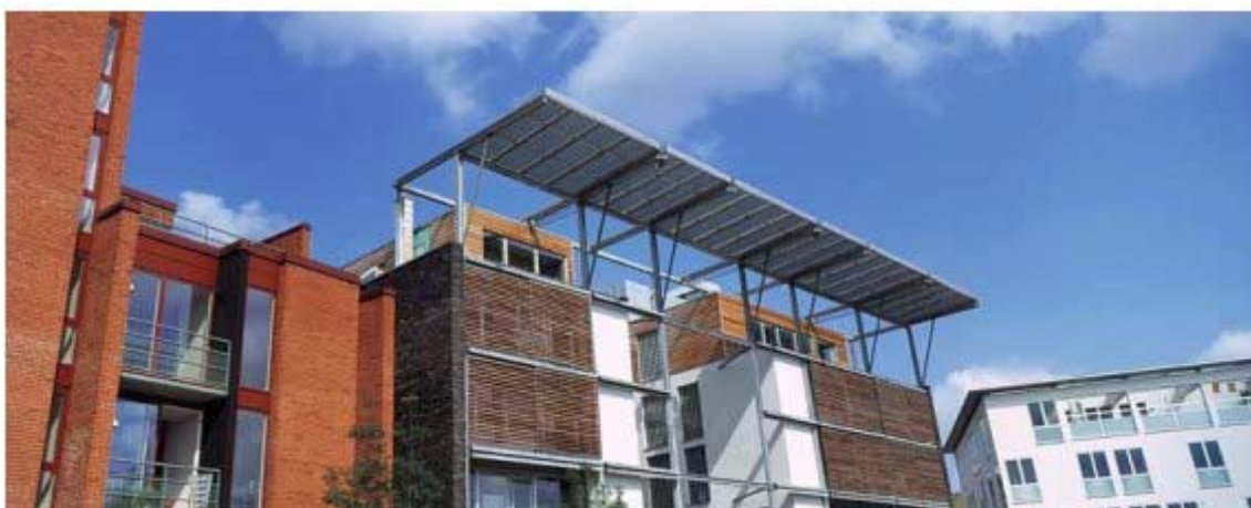
Figur 10.9. Solcellsanläggning på bostadsmässan Bo01 i Malmö
