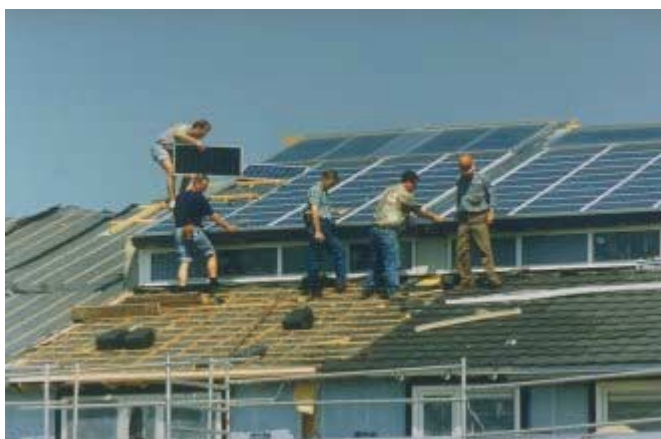
Figur 6.4. Montering av solcellstak i stor skala i Holland. Källa: Ecofys, Holland.
