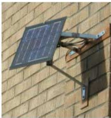
Figur 9.7. Solcellsmodul med toppeffekten 9 W. För bästa möjliga system bör antingen speciella solcellsmoduler tas fram som passar kondensatorns spänningsintervall eller så måste en laddningsregulator konstrueras som kan anpassa spänning och ström från standardpaneler till kondensatorn.
