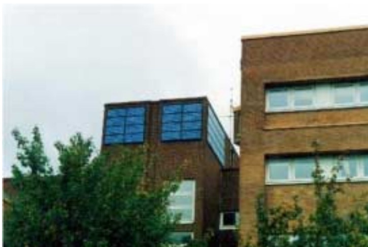
Figur 5.4. Solceller på fasad på Sydkraft/Carl Bros kontorsvägg i Malmö.
