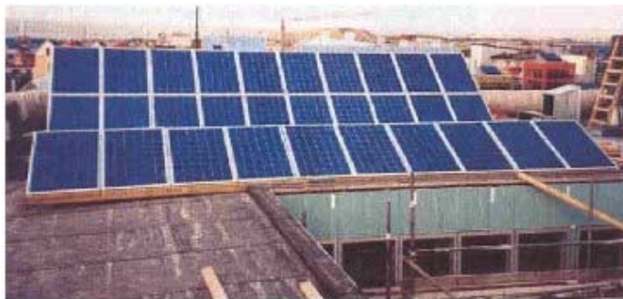
Figur 5.3. Takinstallation på Harmonihus.
