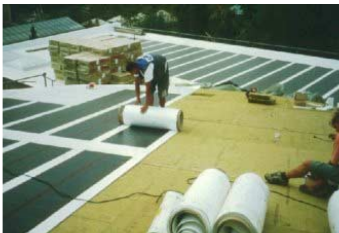
Figur 6.3. Flexibla laminat för takapplikationer förenklar hantering och installation av solceller. Källa: Uni-Solar – Bekaert ECD Solar Systems LCC, Belgien, foto: Alwitra GmbH, Tyskland.
