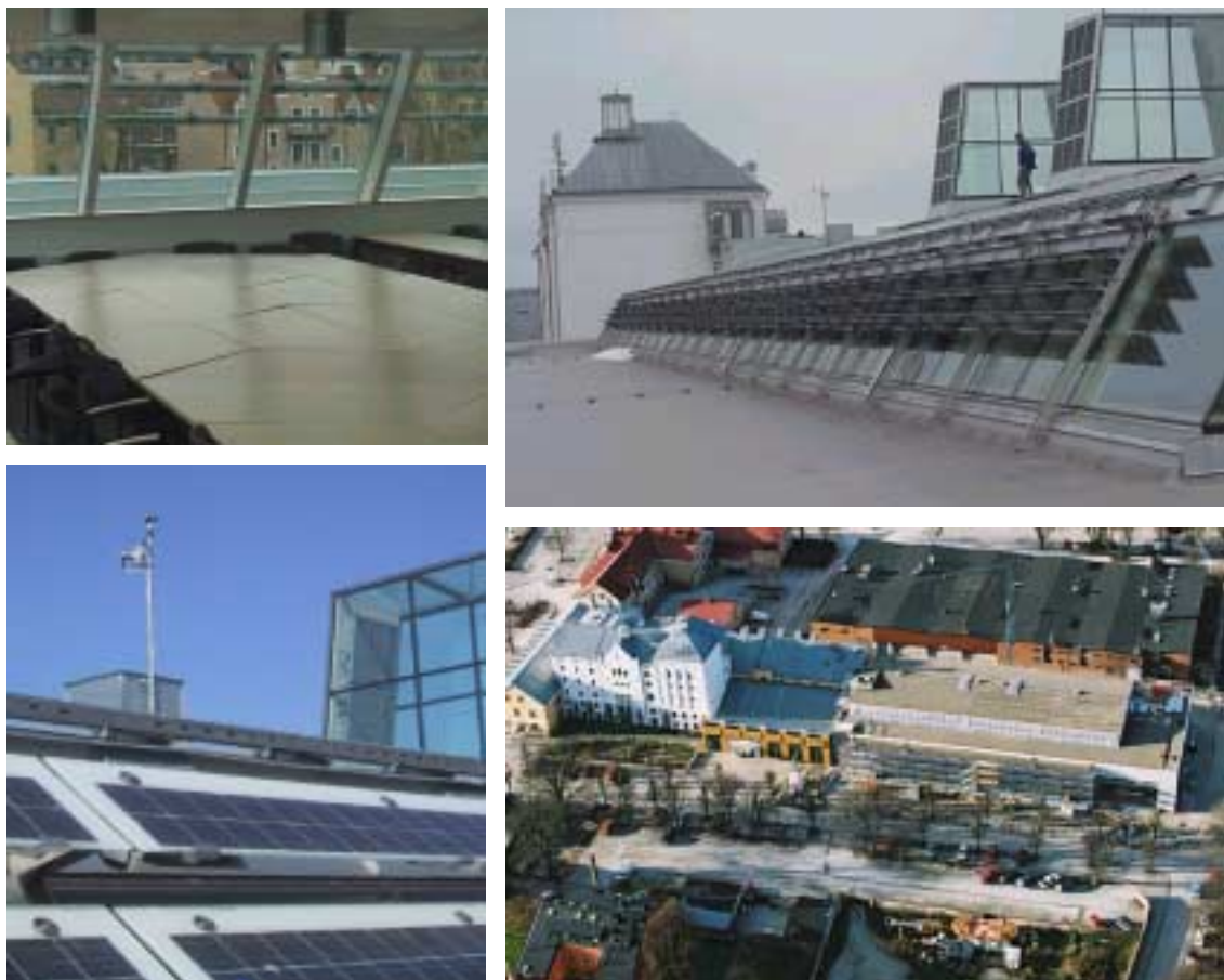
Figur 5.8. Vy från lekionssal (övre vänster), vy från taket (övre höger), solceller och väderstation (nedre vänster) samt flygfoto av byggnaden under uppförande (nedre höger).
