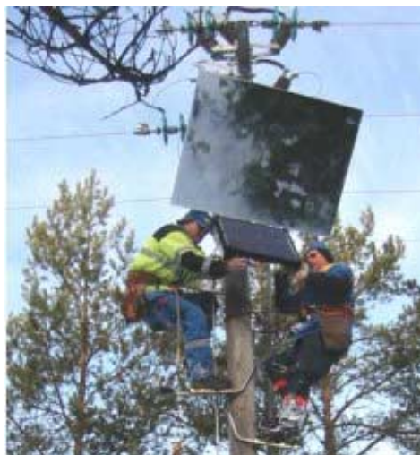
Figur 9.3. Foto från montagearbetet av ett reflektorpaket i fält.
