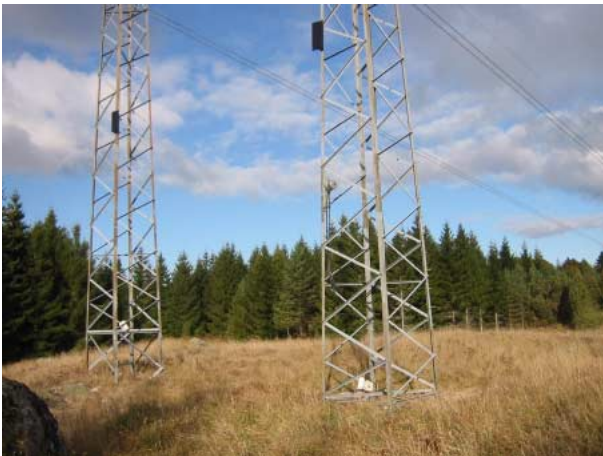
Fig.8. En solcell placerades i varje stolpben.
