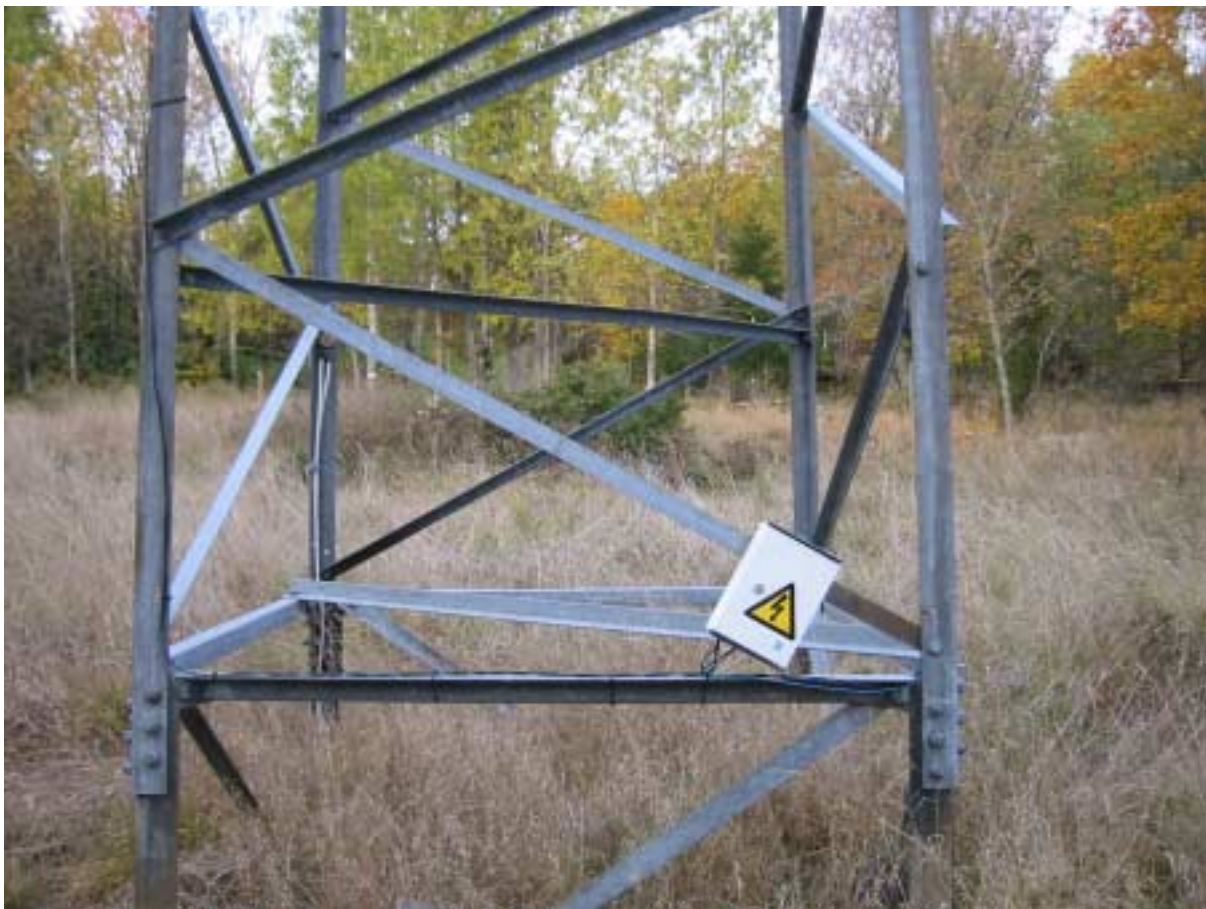
Figur 10. En kopplingslåda placerades i stolpen ovan mark.
