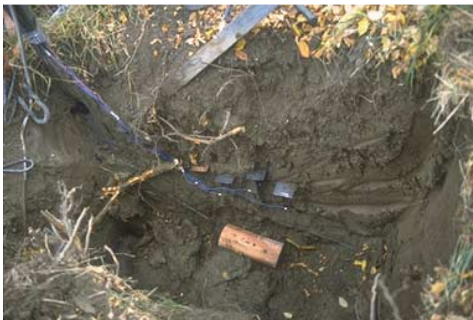
Fig 11. Provplåtar och stationär referens nedgrävdes vid fundamentet.
