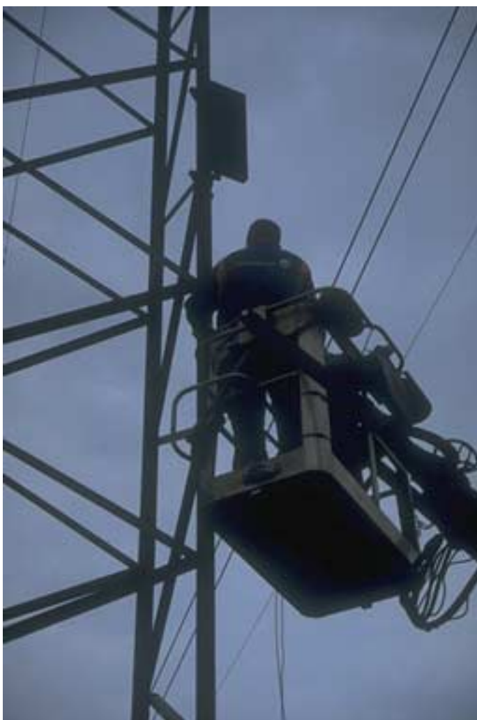
Figur 9. Solcellen monteras med hjälp av kran.
