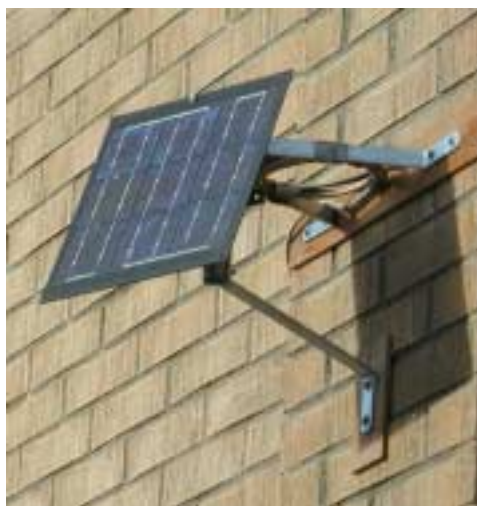
Figur 2.2 Solcellsmodul med effekten 9 watt.
