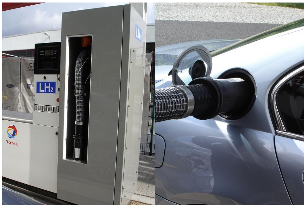
Figur 7: 'Pump' för flytande vätgas och tankning av BMW (foto: H Pohl)
