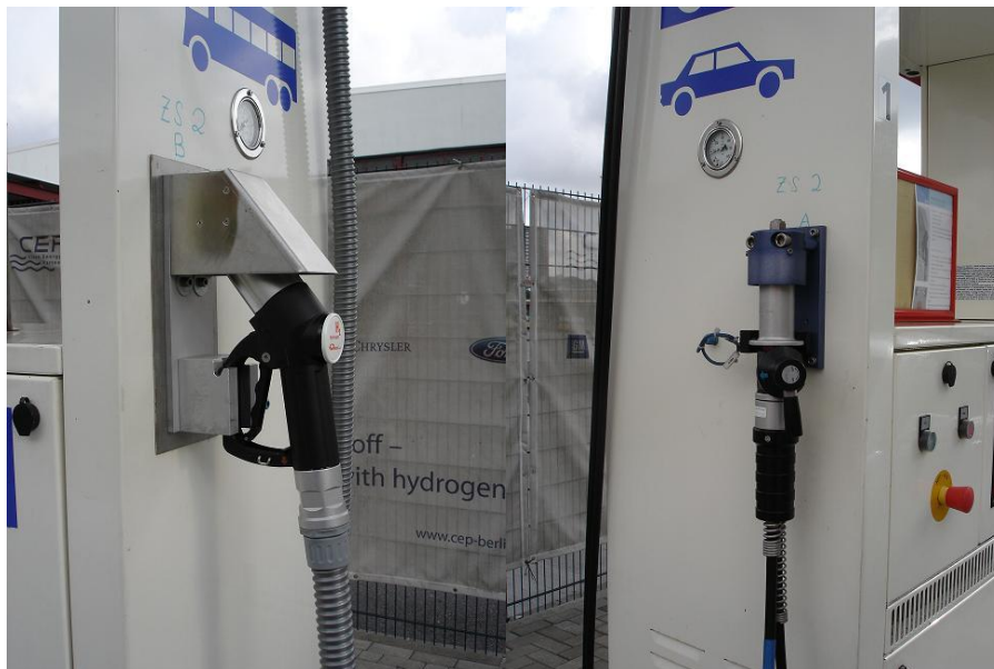
Figur 6: 'Pumpar' för trycksatt vätgas 700 bar t v, 350 bar t h (foto H Pohl)
