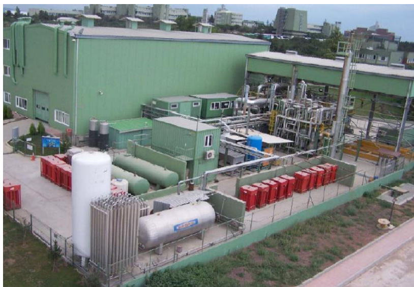
Fig. 8. Den landbaserade försöksanläggningen för marina tillämpningar (MCFC-NAV) vid Marmara Research Center, Turkiet.
