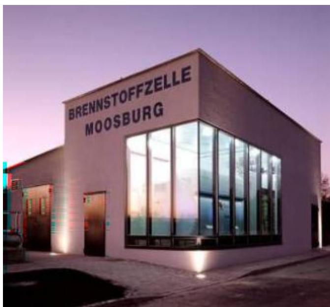
Fig. 4. MTU Onsite Energys bränslecellsystem installerat i kommunal avloppsreningsanläggning i Moosburg, Tyskland. Den drivs med rötgas från anläggningen och använder producerad värme till förbehandling av slam.
