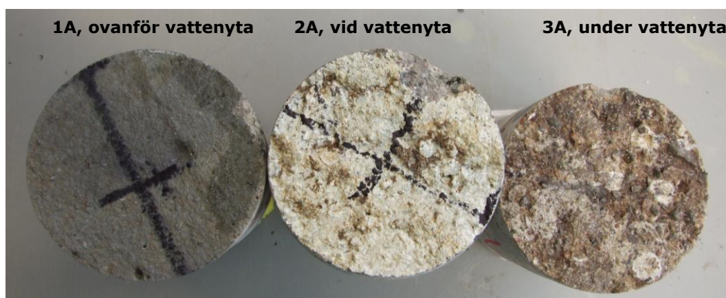
Figur 25: Utseendet hos uttagna betongkärnor med sprutat zinksikt
