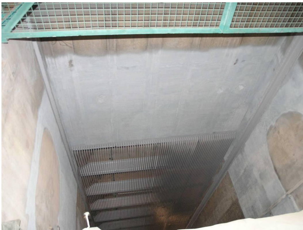
Figur 3: Termiskt sprutad vägg vid silgata, Forsmark
