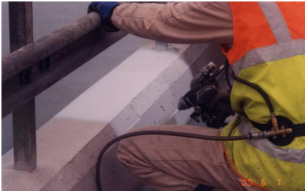
Figur 2: Termisk sprutning av kantbalken med flamsprutningsteknik, Ölandsbron
