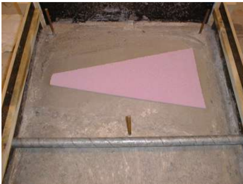
Figur 4.9 Skiva 7 mm av markisolering fastlimmad på härdad betongyta
