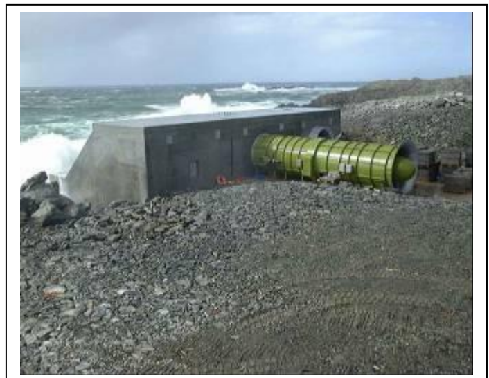
Det landbaserade OWC kraftverket Wavegen LIMPET 0,5 MW power plant installerad på ön Islay i Scotland
