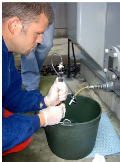
Figur 16 Provtagning av transformator B
