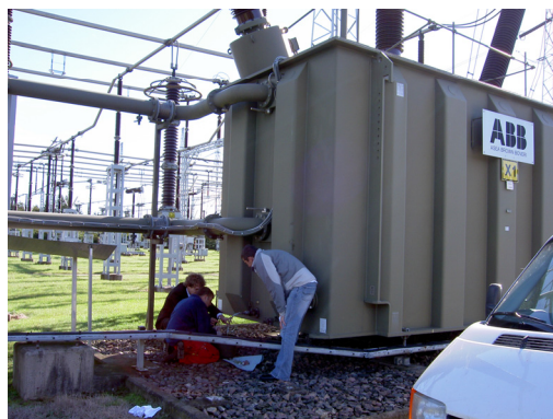
Figur 17 Provtagning från Shuntreaktor
