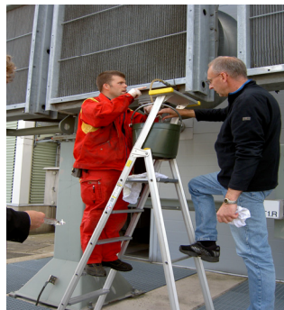
Figur 20 Provtagning från transformator E
