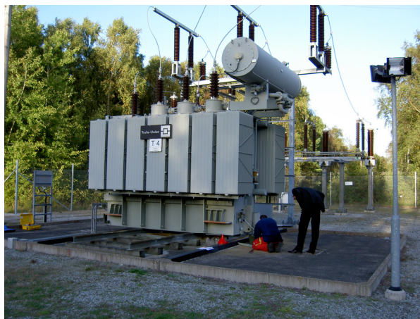
Figur 22 Provtagning på Transformator I
