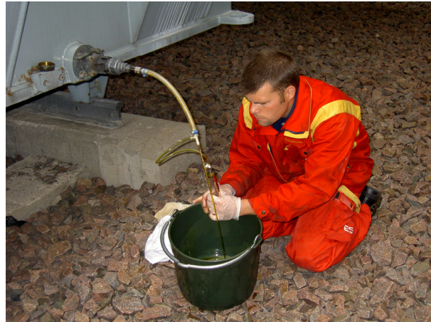
Figur 18 Provtagning från Transformator C
