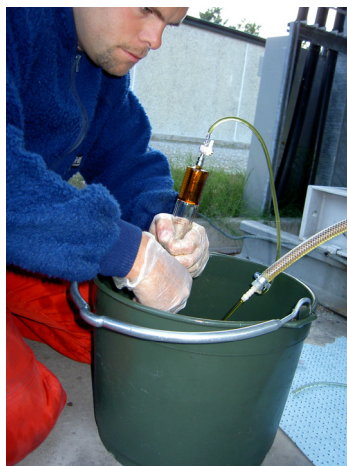
Figur 21 Provtagning på Transformator H
