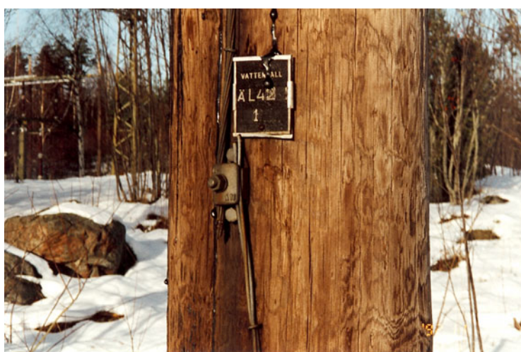
Figur 1 Trästolpe med jordningslina (foto M. Forssander)
