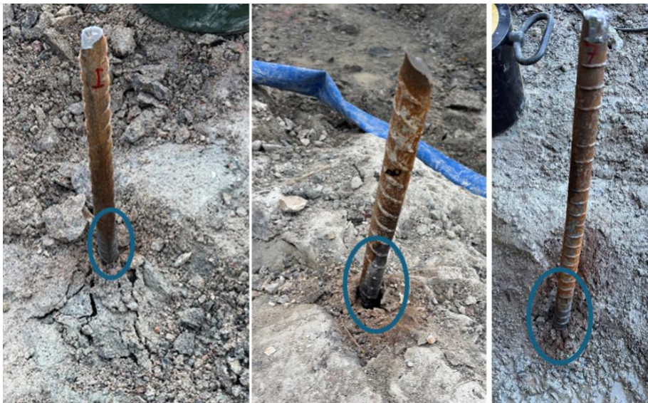
Figur 8. Bilder på kamstål där brottet skett i stålet, från vänster bergförankring 6, 10 och 11. I vänstra bilden har även ett ytligt brott i bergmassan inträffat i samband med provningen. De delar av bergförankringen som dragits upp ur berget är i väldigt bra skick utan någon synlig korrosion, se de blå cirkelarna.
