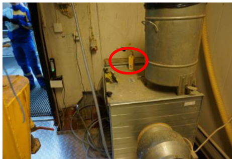
Figur 17 Bio-Bränslestoftsändare
