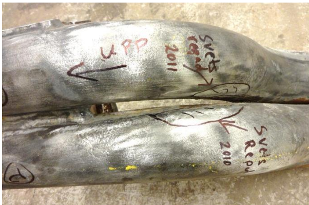
Bild 10:1. Läge för svetsreparationer är markerad i den översta tuben.
