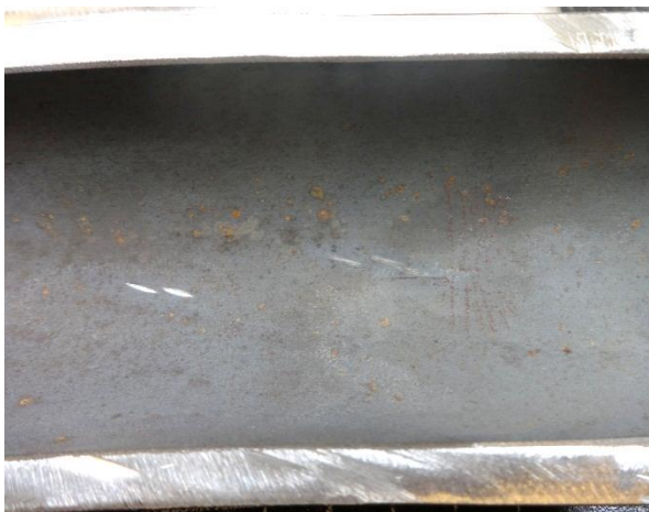
Bild 12:3. Utseende hos insidan. Inga spår av korrosion.
