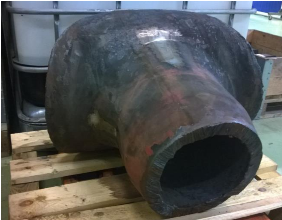
Figur 53. T-stycke av 10CrMo9-10 från Heleneholmsverket med krypskador.
