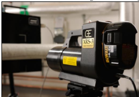
Figur 30 Uppställning för digitalröntgenundersökning av rörledning (detektor för digitalröntgen i bakgrunden)
