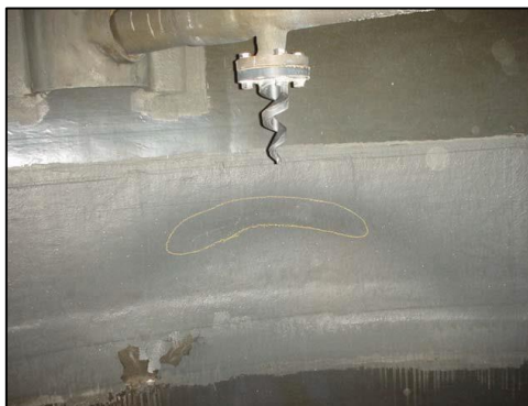
Figur 67 Nötning från en dysa på en skrubbevägg
