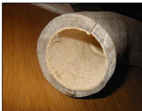
Figur 70 Erosion i ett rör p.g.a. ojämnt flöde
