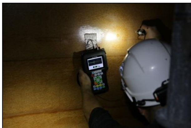
Figur 27 Mätning med ultraljud på en blåsa i en skrubber
