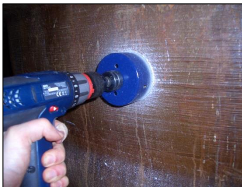
Figur 14 Rondelluttag ur en tankvägg görs exempelvis med en hålsåg
