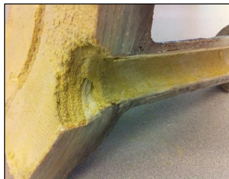
Figur 66 Korrosion vid ett påstick
