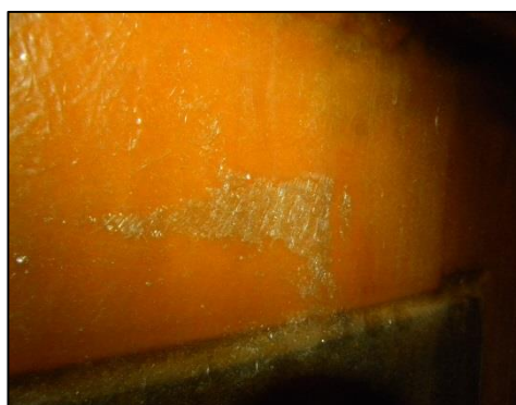
Figur 85 Icke vätta fibrer på utsidan av en skrubbermantel
