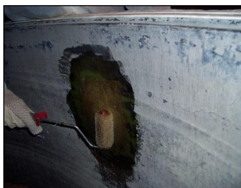
Figur 19 Nytt laminat i form av ett nytt spärrskikt byggs upp på insidan av manteln
