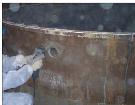
Figur 17 Ytan runt rondelluttaget slipas ner
