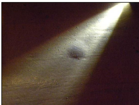
Figur 49 Blåsa i släpljus från ficklampa
