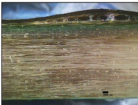
Figur 45 Tvärsnitt av en blåsa i spärrskiktet i en saltsyratank
