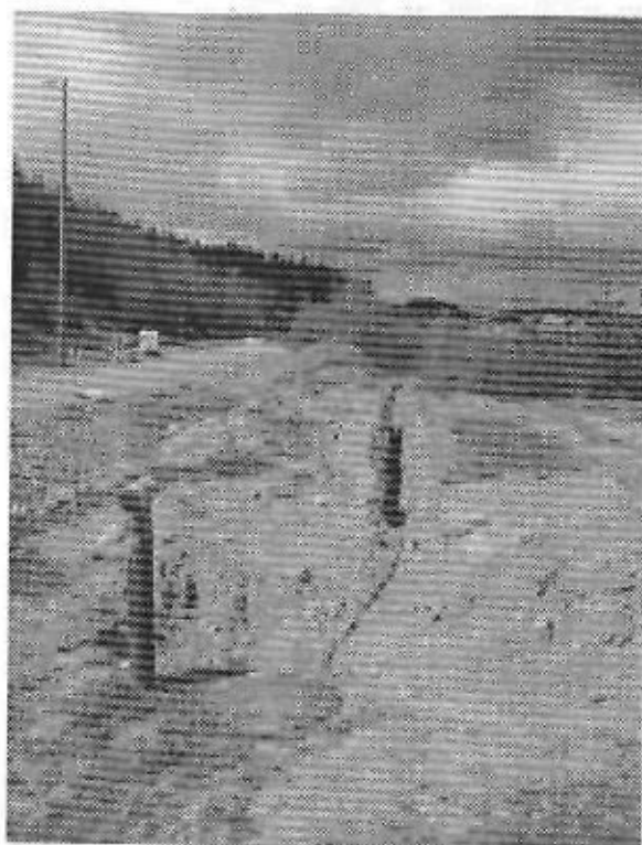
Bild 25. Kabeln installerades ovanpå kulverten.
