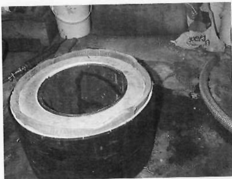
Figur 8-9. Foto som visar placeringen av bentonitremsan i det spår som frästs ut i skumytan på det ena rörstycket.
