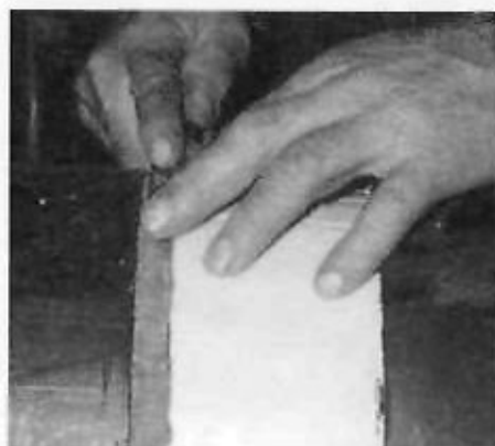
Figur 8-6. Bentonitremsan placeras på plats innan mantelröret skjuts på
