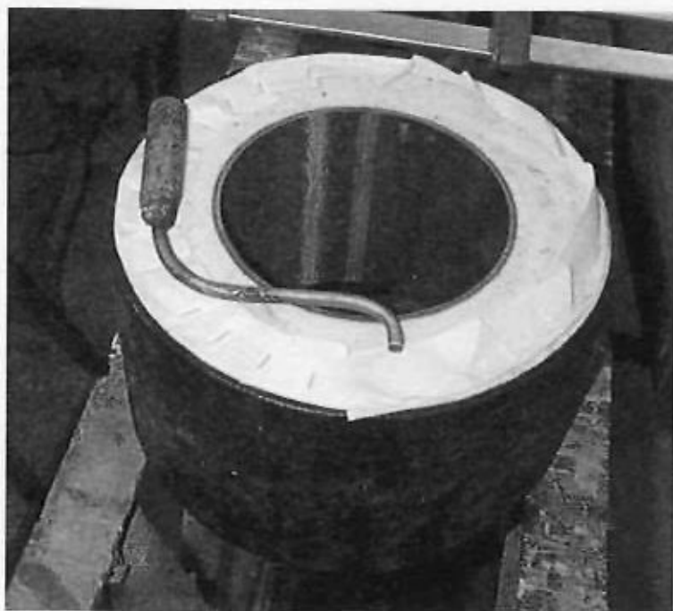
Figur 8-11. Den veckade vattenabsorberande tejpens placering på isoleringens ändyta. I bilden syns även den studs genom vilken vatten tillförs i gränsytan mellan mantelrör och skum innan den placerats i rätt läge.
