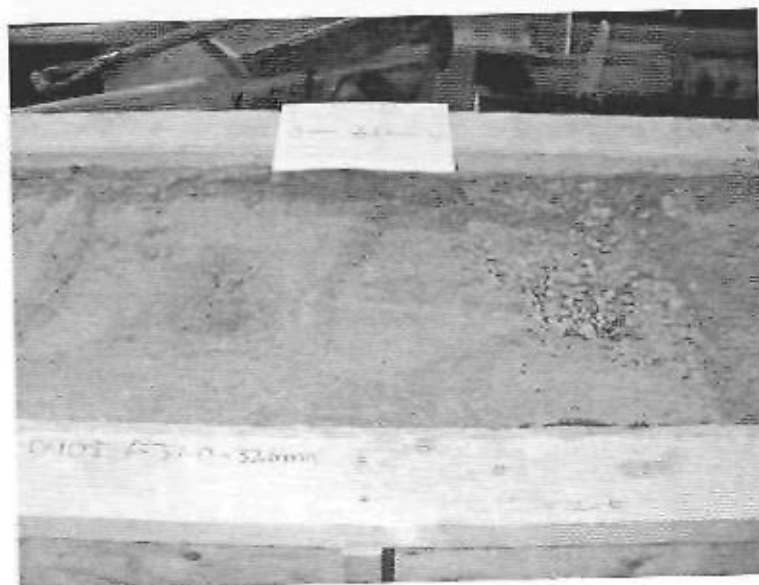
Figur 4.28 Hålrum till följd av omfördelning av kringfyllningsmaterial. Elektrosvetsmuff körd 1000 cykler i 0 – 32 mm. Cavity caused by redistribution of backfill material. Fusion welded joint after 1000 cycles in 0 – 32 mm.
