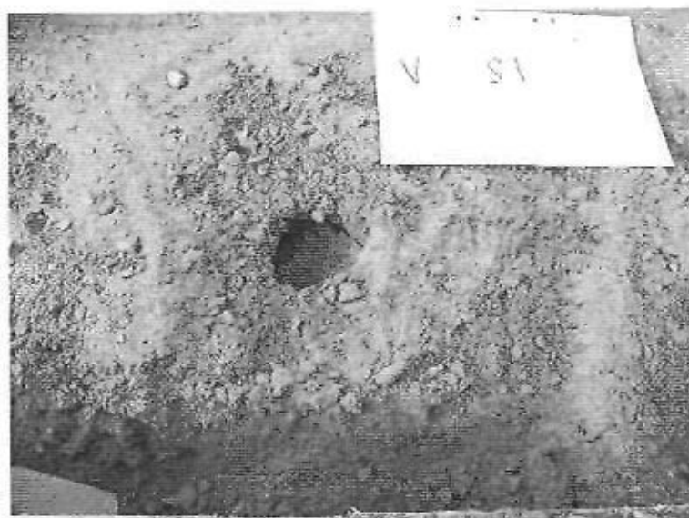
Figur 4.11 Hålrum till följd av omfördelning av kringfyllningsmaterial. Skjutmuff efter 130 cykler i 0 – 16 mm. Cavity caused by redistribution of backfill material. Sealed oversize joint after 130 cycles in 0 – 16 mm.
