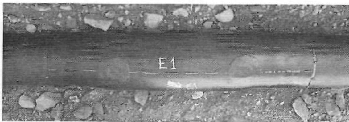
Figur 3.6 Färdig elektrosvetsmuffskarv. Complete fusion welded joint.
