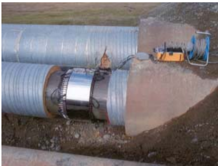
Figur 2. Ultraljudprovning enligt Teletestmetoden av stålrör under väg, ref [1].
