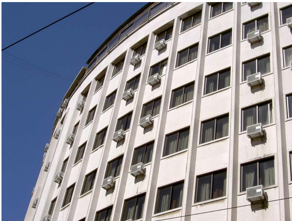
Bild 1 En allt vanligare syn är små ineffektiva luftkonditioneringsaggregatet utanför stora byggnader. Bilden är tagen av Magnus Rydstrand (en av författarna) utanför ett hotell i Lissabon.
