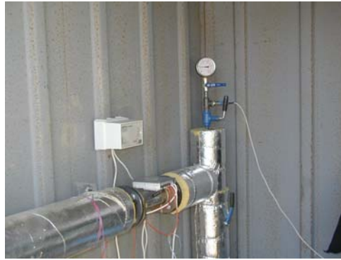
Figur 2.6 a,b: Inredning av mätcontainern. a) (Till vänster): Anslutning till huvudledningen. b) (höger): Fjärravläsningsenhet och tryckgivare.
