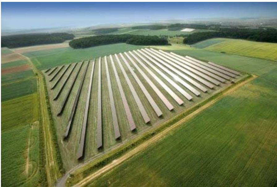
First Solar installation med CdT tunnfilmsmoduler
