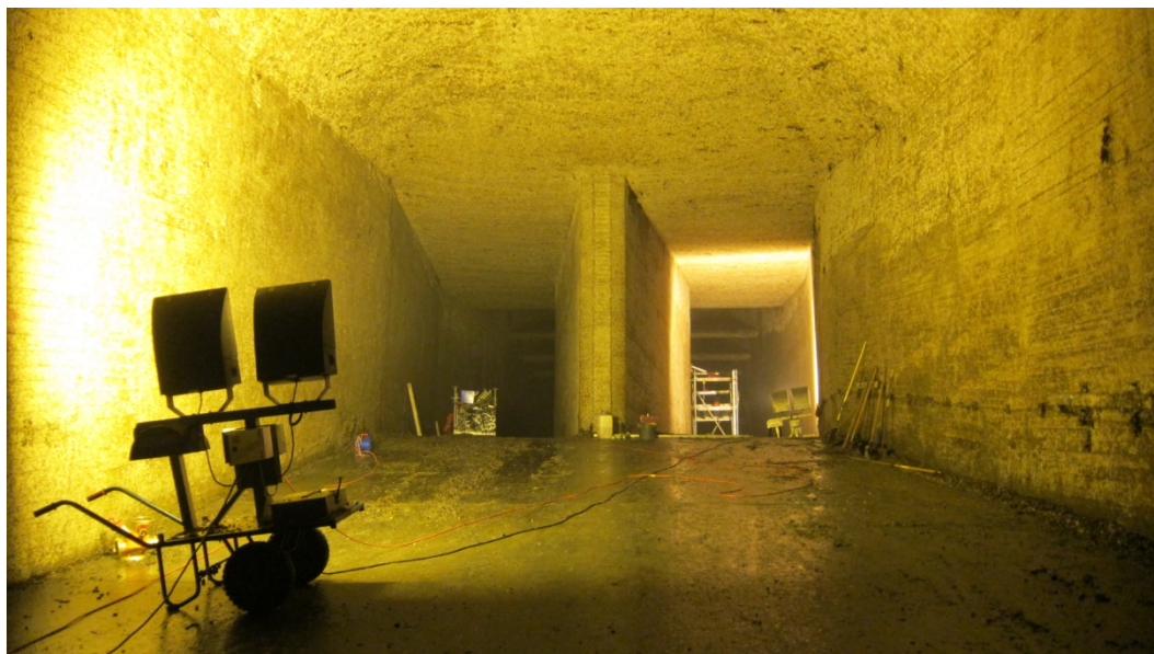
Figur 3. De båda kanalerna sedda från inloppskulverten.
