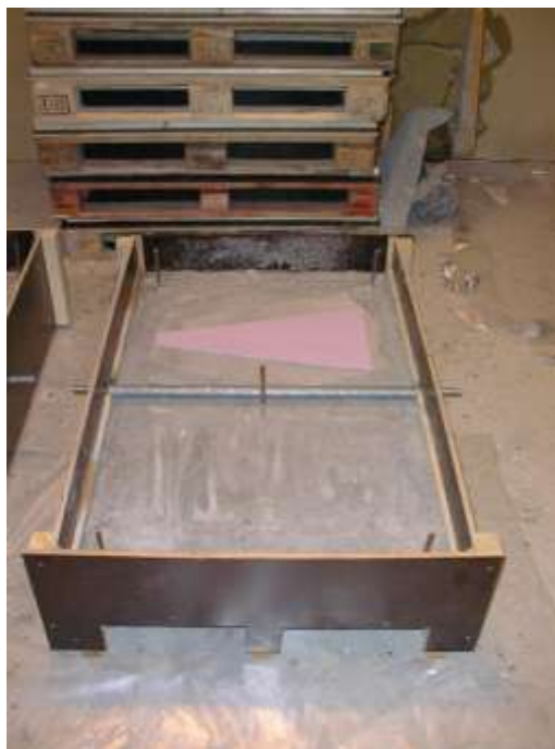
Figur 5. Provyta P2s2 sedd underifrån vid igjutningen av cellplastskivan på djupet 120 mm. Skivan klistrades fast på ett 120 mm tjockt betongskikt så fort detta härdat.
