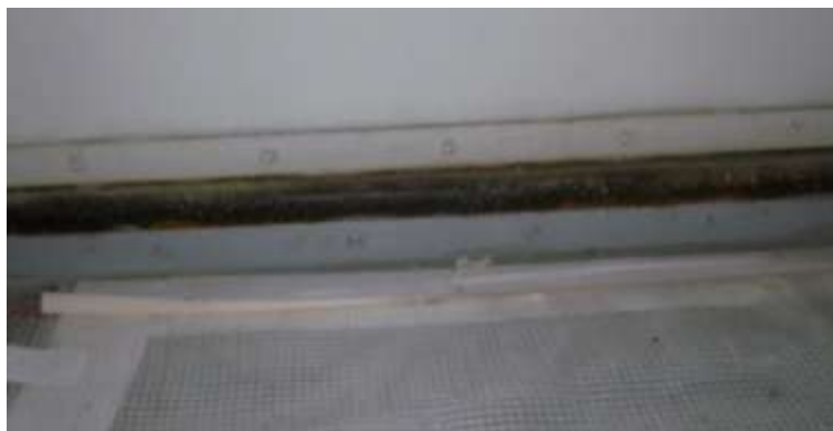
Figur 5.17 Gamla avtätningen mellan reaktorinneslutningen och övriga byggnader. Dilatationsfogen bestod av ett gummimembran av neoprengummi ovanpå antingen cellplast, träfiberskiva eller isolering.
