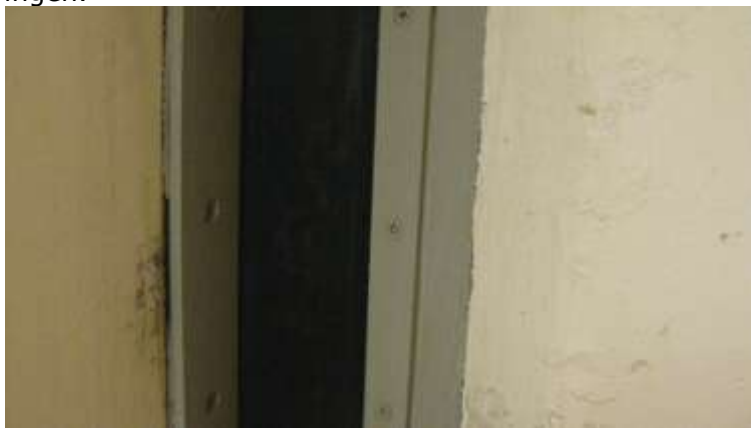
Figur 5.5. Membrangummitätning mellan betongblock på O3. Avtätningen används för att separera spalten som finns mellan reaktorinneslutningen och andra konstruktioner och ska fungera som skydd för vatten och ånga. Innanför avtätningen finns en brandisolering som ska förhindra spridning av brand till andra block.
