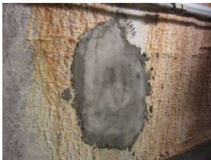
Figur 4.4. Lagning av vägg under dammkonstruktionen i Älvkarleby i gamla stationen. Materialet är av typen epoxi.
