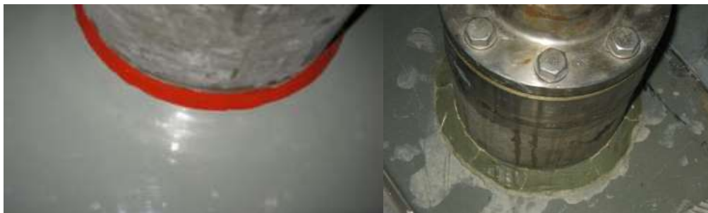
Figur 5.2. Silikonfogar i O3 reaktorslutningen, bilden till vänster visar en ny fog och bilden till höger visar en åldrad krackelerad fog. OBS, fogmassorna är inte av samma typ, färgskillnaderna är inte på grund av åldringen.
