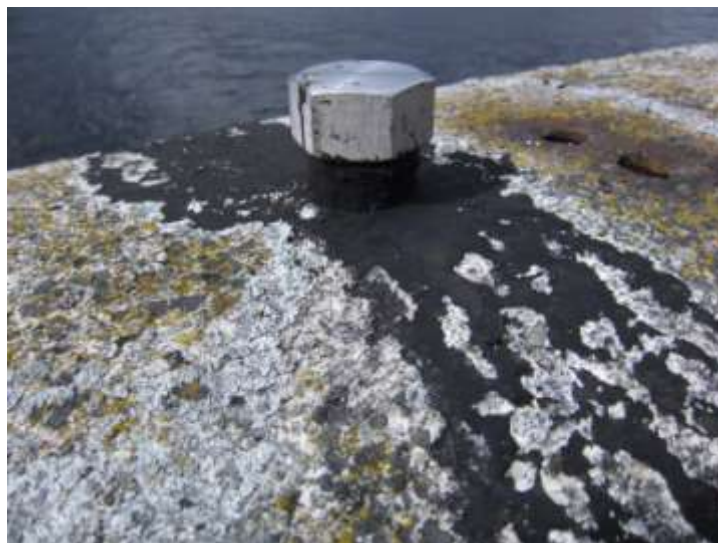
Figur 4.2. Plats där man fyller på bitumenmassan mellan fogbanden, den svarta massan är bitumenmassan.
