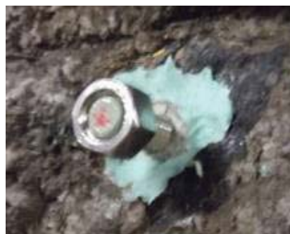
Figur 7 Tätning av spalt mellan och cementcylinder och berg (Sealing of the gap between the rock and the concrete cylinder).
