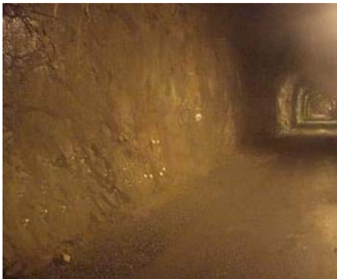
Figur 2 Äspötunneln (The Äspö tunnel)
