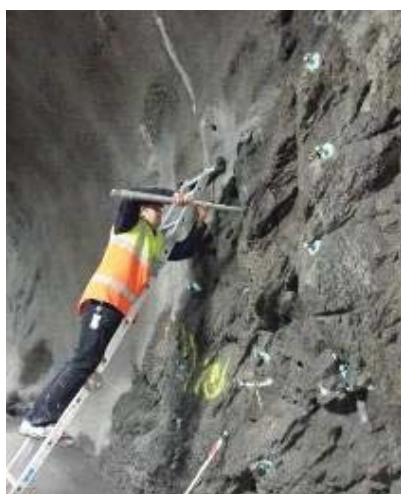
Figur 4 Montering av provkroppar i förborrade hål i Muskötunneln (Mounting of rock bolts in drilled holes in the Muskö tunnel).
