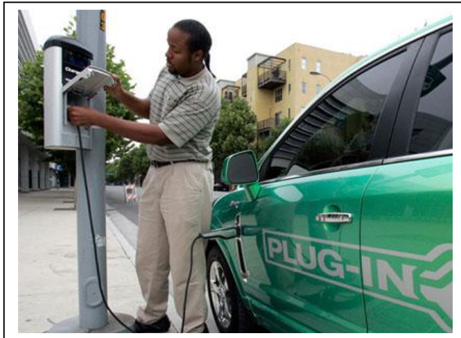
Figur 5.1 Bilden visar en laddstationen för "Chargepoint Network", ett system för smart laddning, från Coulomb Technologies i USA.
