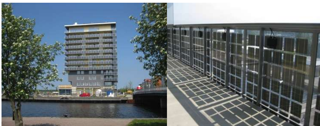
Figur 9. Integrering av solceller i balkonger på ett bostadshus i Gävle.
