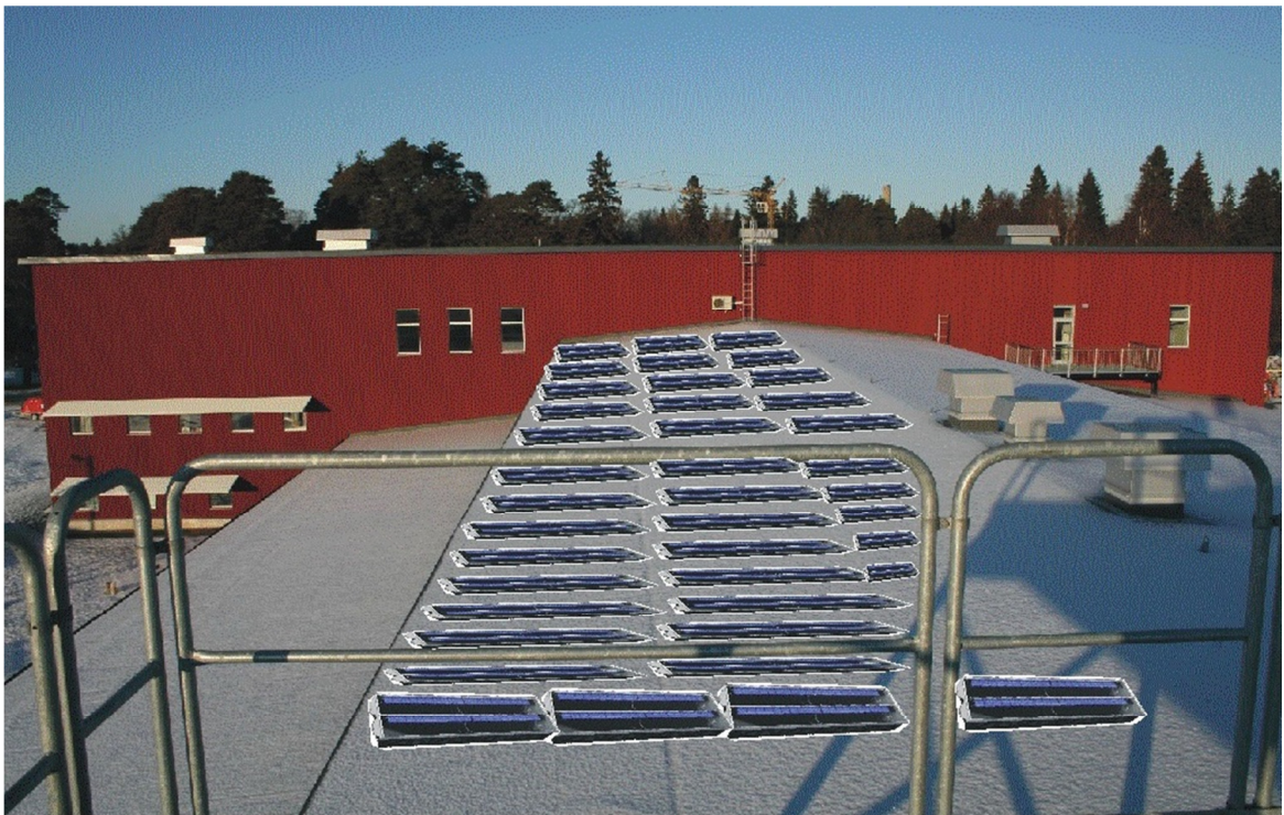
Figur 6. Den nya laboratoriebyggnadens nära platta nord-sydliga tak med 45 moduler motsvarande 110 m 2 solföljande Blendahybrider i ett bildmontage.
