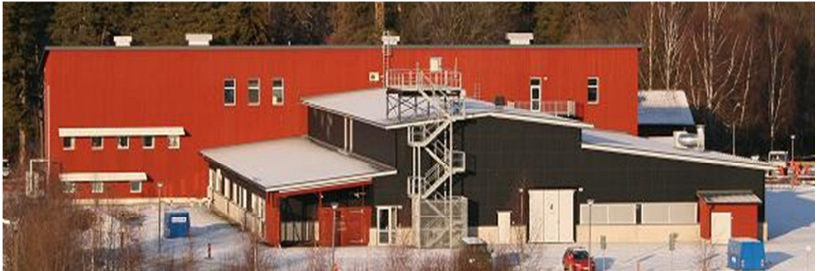
Figur 5. Den nya laboratoriebyggnaden där Blendahybrider skall installeras. Den röda byggnaden är uträckt i östvästlig riktning och den svarta byggnaden är uträckt mot söder.
