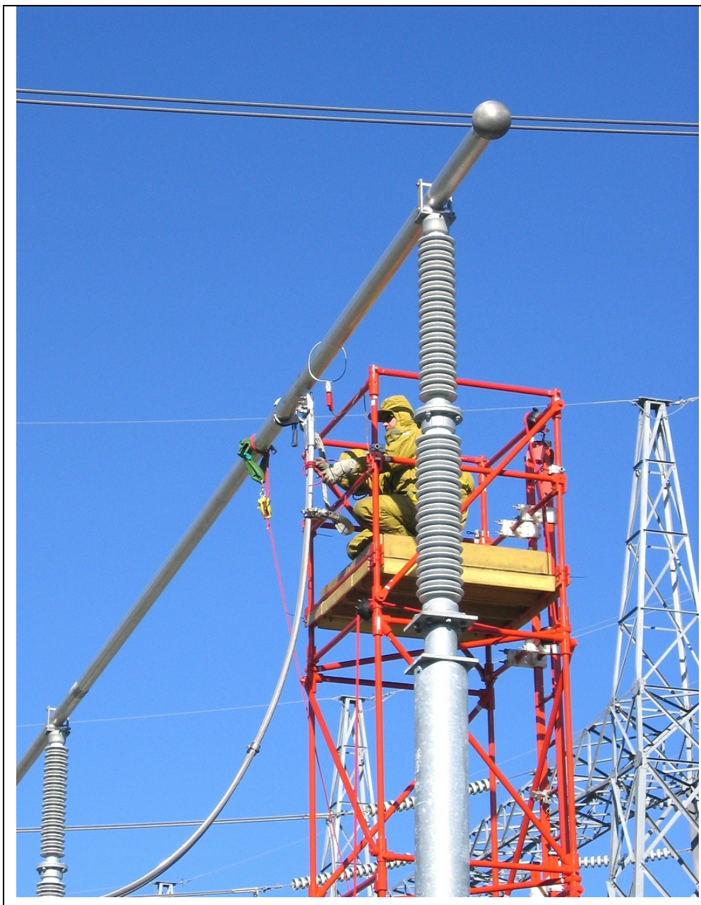
Figur 2. Arbete med barhandsmetoden med en slack vid samlingsskenan. Arbetet sker från en isolerande ställning och montörerna bär ledande dräkt. Den runda klämman med rött handtag som sitter om röret visar att de är potenti- almässigt kopplade till skenan. Foto Johan Andersson, Vattenfall Power Consultant AB.
