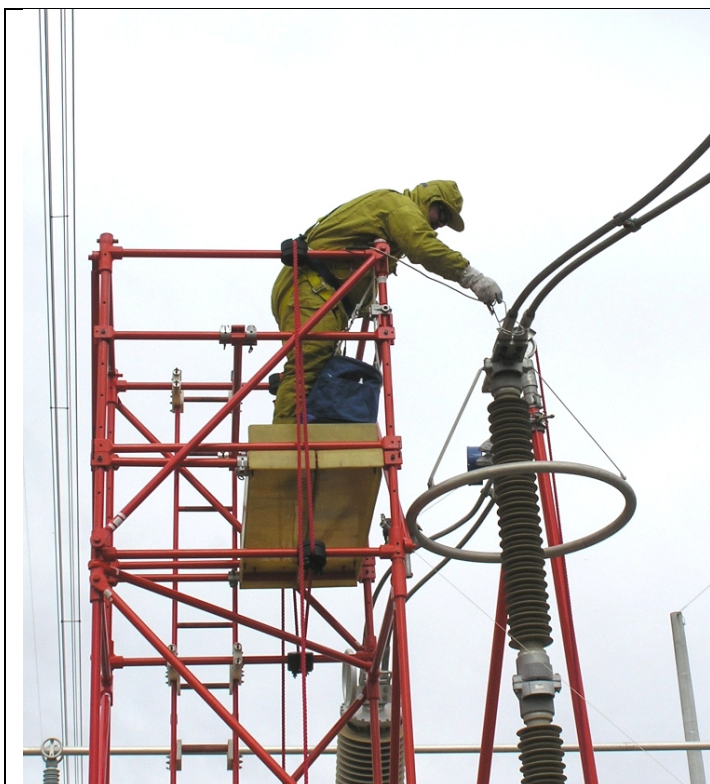
Figur 4. Arbete med barhandsmetoden på en ventilavledare. Foto Johan Andersson, Vattenfall Power Consultant AB.
