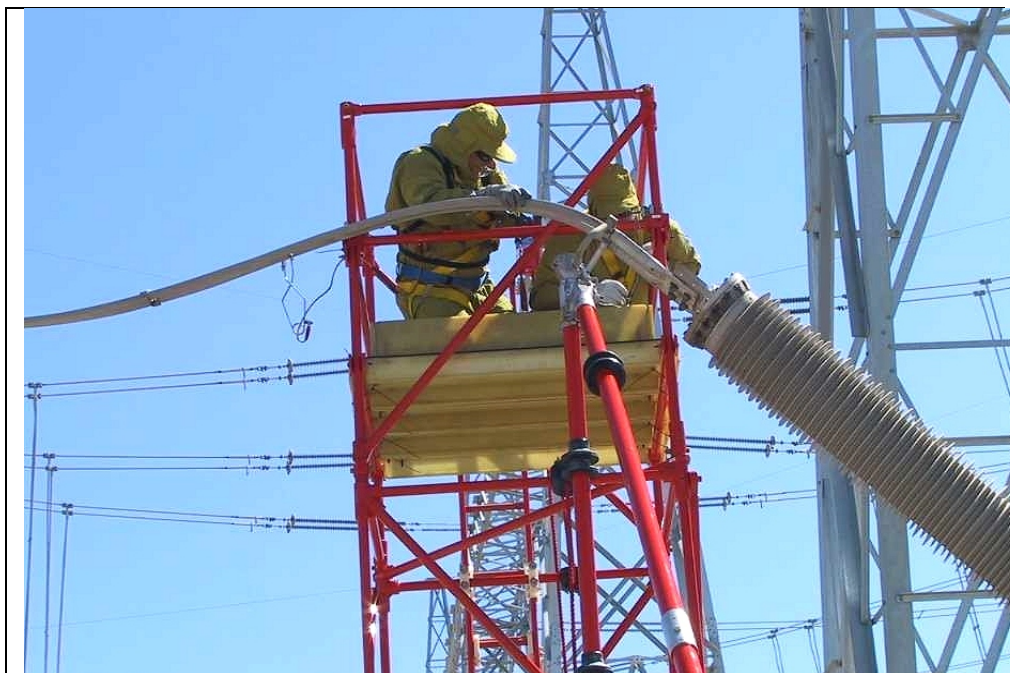
Figur 3. Arbete med barhandsmetoden på anslutningen till en brytare. Foto Johan Andersson, Vattenfall Power Consultant AB.
