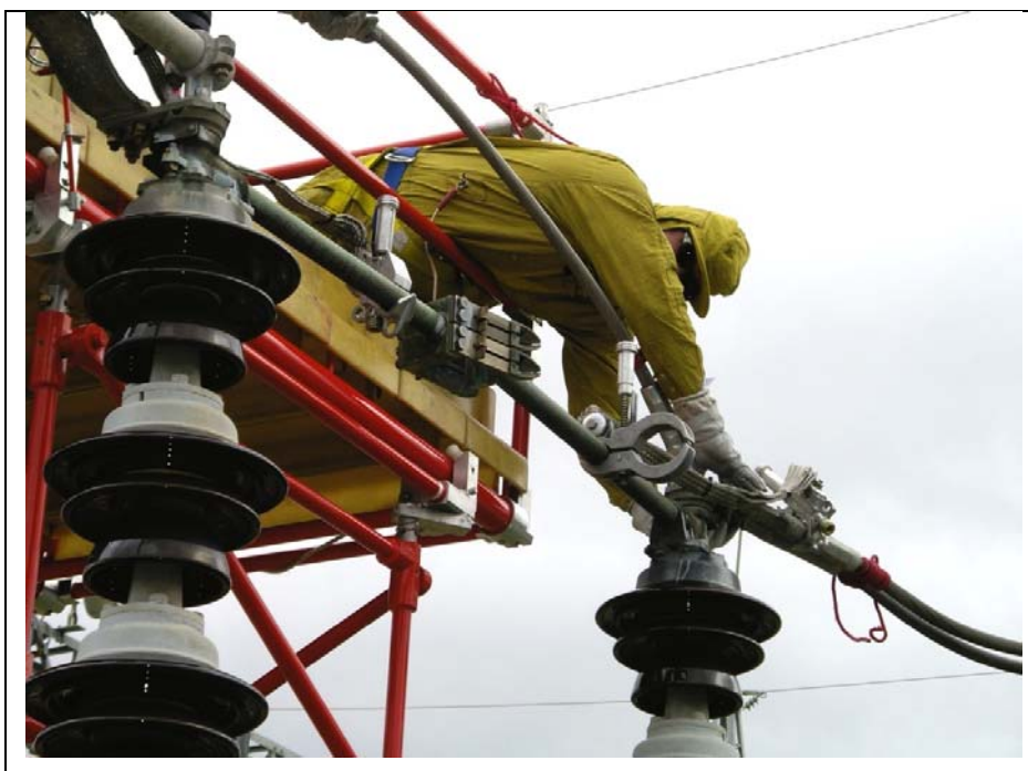
Figur 6. Montage av strömshunt på en frånskiljare. Foto Johan Andersson, Vattenfall Power Consultant AB.
