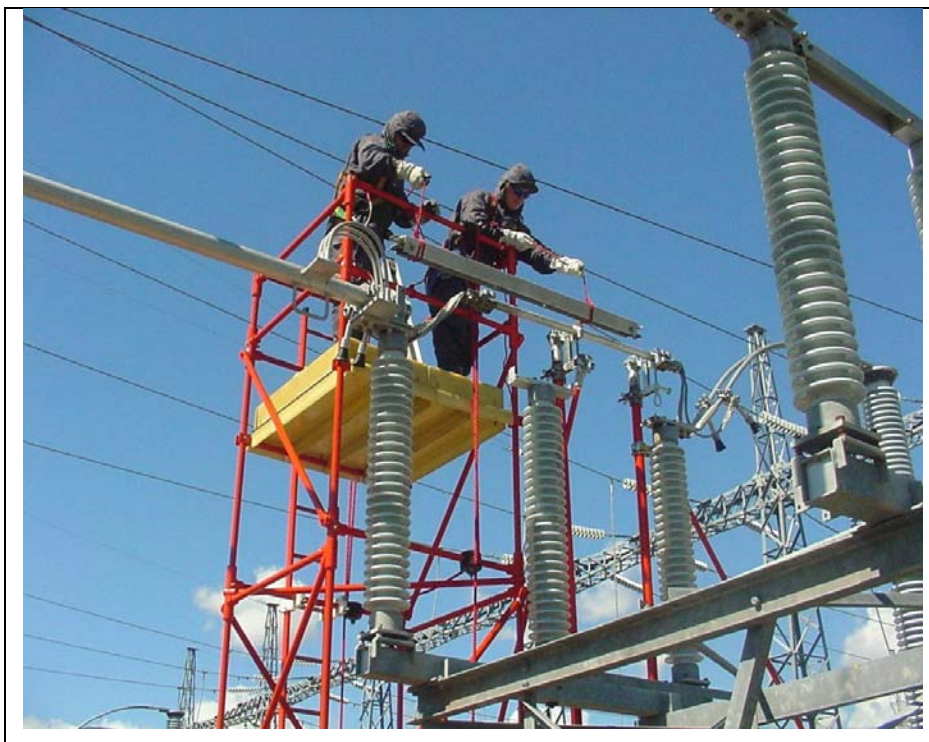
Figur 5. Byte av strömbana på en frånskiljare med barhandsmetoden. Frånskiljaren är under arbetet kortsluten med en temporär strömshunt. Foto Johan Andersson, Vattenfall Power Consultant AB.
