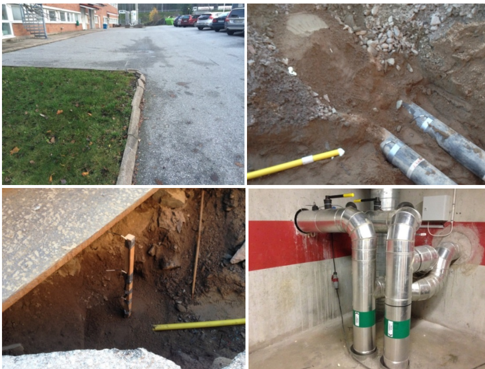
Figur 6: Parkering före installation vid mätplatsen i Kista överst vänster. Installation av MP1-2 i schakt. Kablar till givare ligger i stenmjöl 0-8 mm nära givarna och för övrigt i rör till elskåp. Nederst till höger syns elskåp i närliggande byggnad (som ägs av Fastighets AB Balder). Dykrör för temperaturgivare är monterade i rör före passage genom yttervägg. (Foto: Sune Borgström (överst till vänster) respektive Marcus Kempe (övriga))
