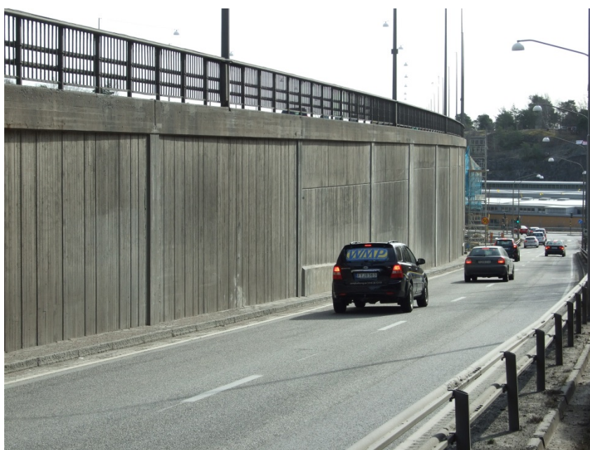
Figur 1 Stödmur på Essingeleden vid avfart Aspudden, Stockholm.
