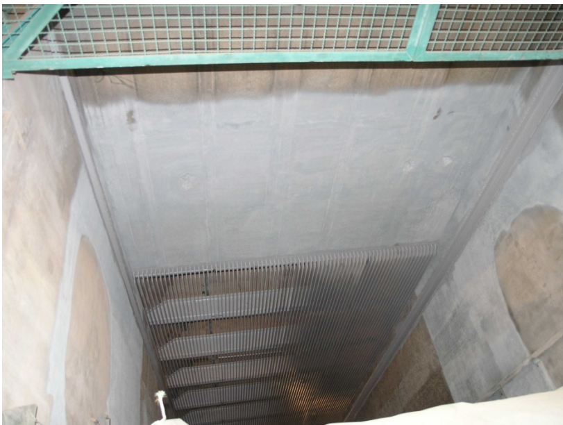
Figur 3 Silgata placerad i intagsbyggnaden för Forsmark 1 och 2
