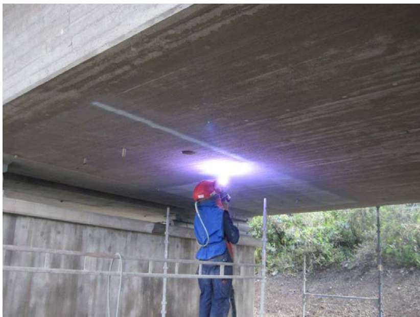
Figur 9 Termisk ljusbågssprutning av zink på undersida brolåda för vägbro 14-884-3 i Göteborg
