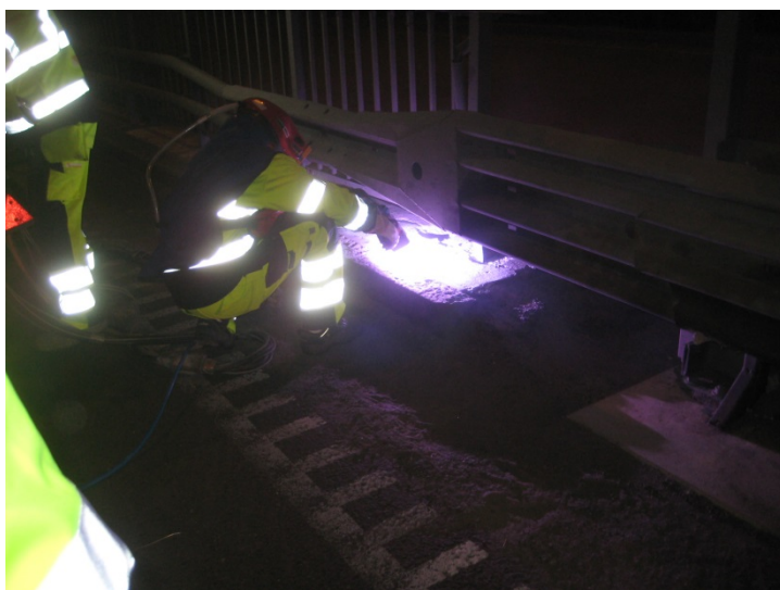
Figur 10 Ljusbågssprutning av kantbalk till stödmur vid Essingeleden Stockholm.
