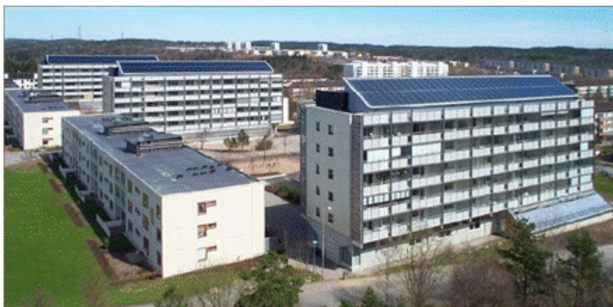
Figur 5.2 Ombyggnad av Gårdstensbostäder
