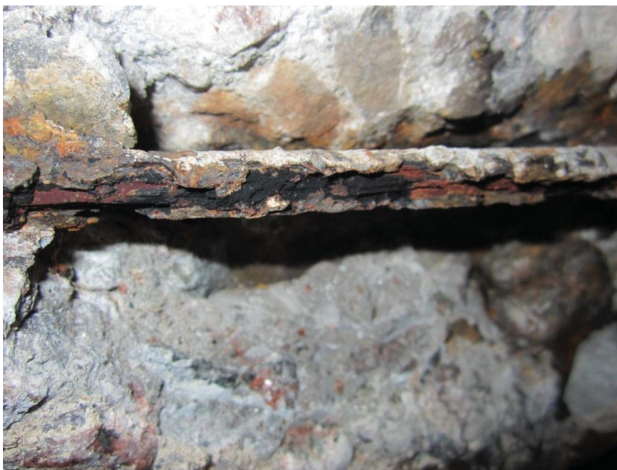
Figur 6.8 Bild på armering i tak, stråk 3, kontrollområde 11, enligt [48].
