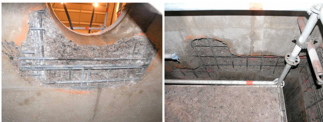
Figur 7.3 Vattenbilade bompartier i tak och vägg, enligt [50].
