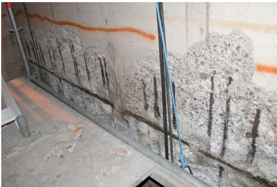
Figur 7.4 Handbilning av lös betong, enligt [50].
