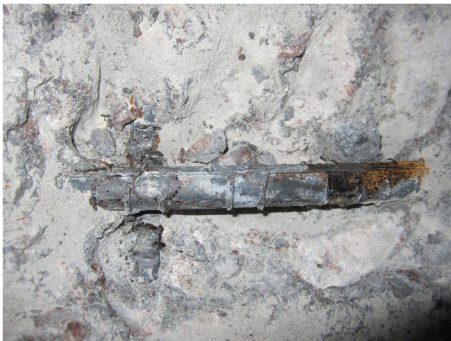
Figur 6.9 Bild på armering i golv, stråk 4, kontrollområde 13, enl. [48].
