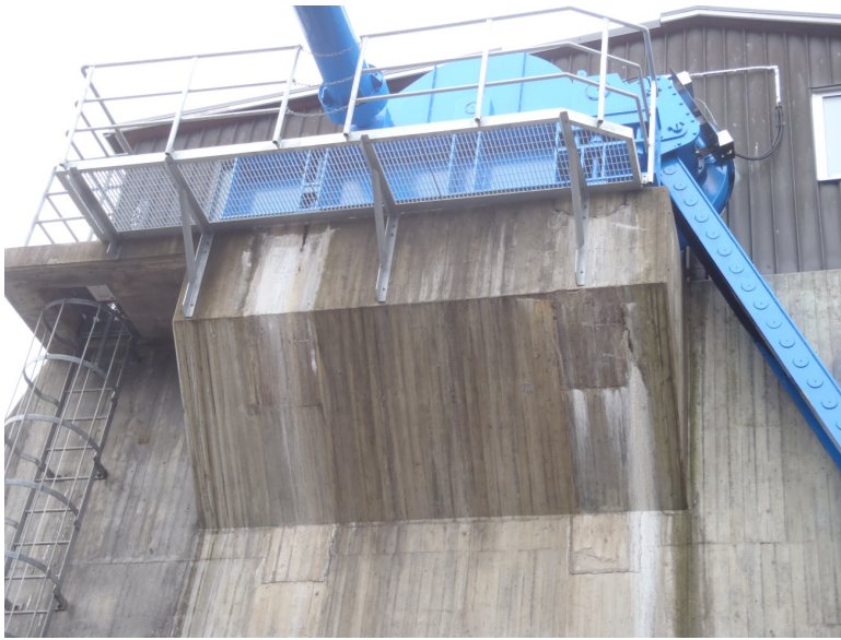
Figur 17. Exempel på kuggspelskonsoll med viss sprickbildning.
