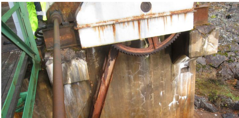
Figur 18. Exempel på kuggspelskonsoll med viss sprickbildning.
