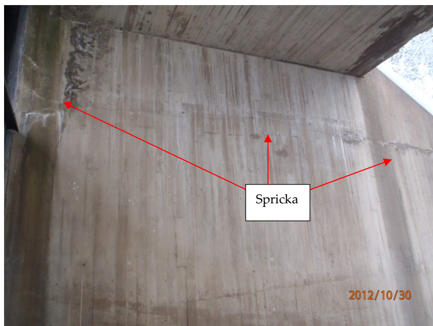
Figur 12. Exempel på horisontell spricka i utskovspelare.
