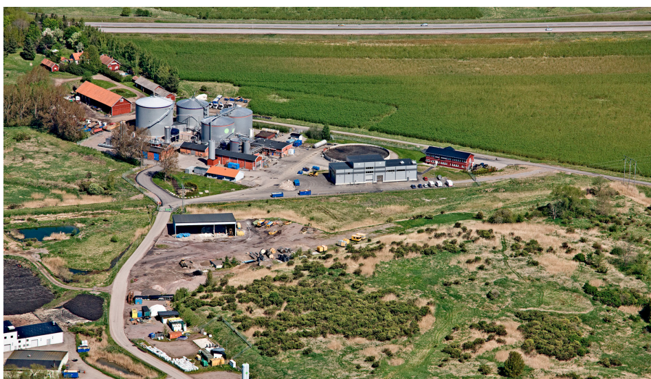
Biogasanläggning med samrötning. Foto: Biogasportalen
