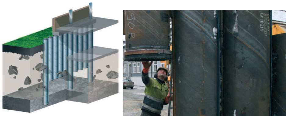
Figur 3.4 - 2 Rörpålevägg som permanent stödkonstruktion för vägg. Till höger rörpålar under montering.
