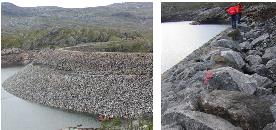
Figur 2.2 - 3 Exempel på ordnat erosionsskydd där blocken orienterats i huvudsak med längdaxeln vinkelrätt mot släntens lutning, Akersvassdammen, Norge.
