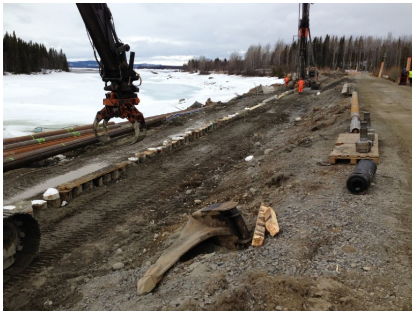
Figur 5.5 – 10 Färdigmonterade spont försedd med skyddsmuffar.
