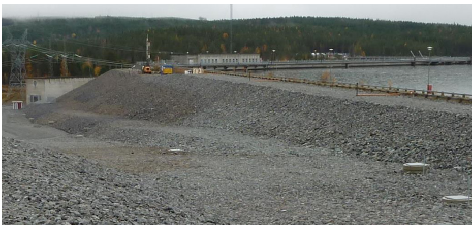
Figur 8.5 - 5 Dränering och stödbank mot nedströmsslänten färdigställd 2013.
