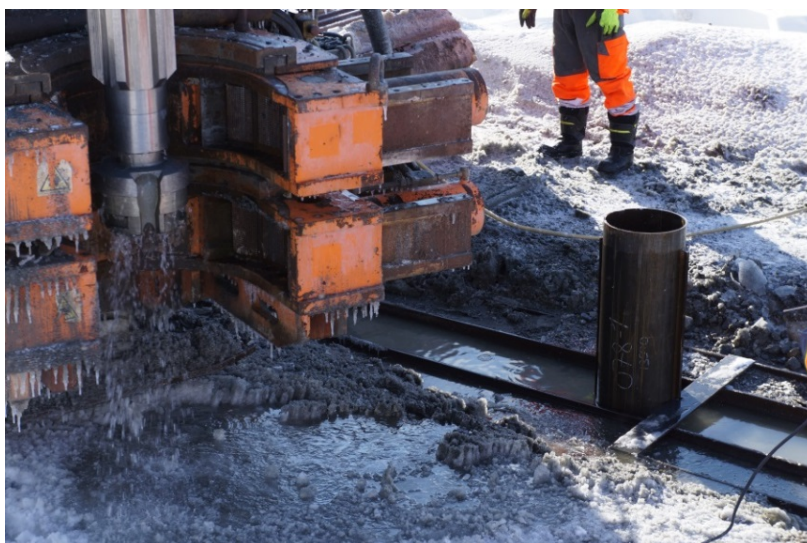
Figur 5.5 - 6 Färdigmonterat rör innan kapning. De färdiginstallerade pålarna kapades ca 0,5 m under den blivande krönytan.
