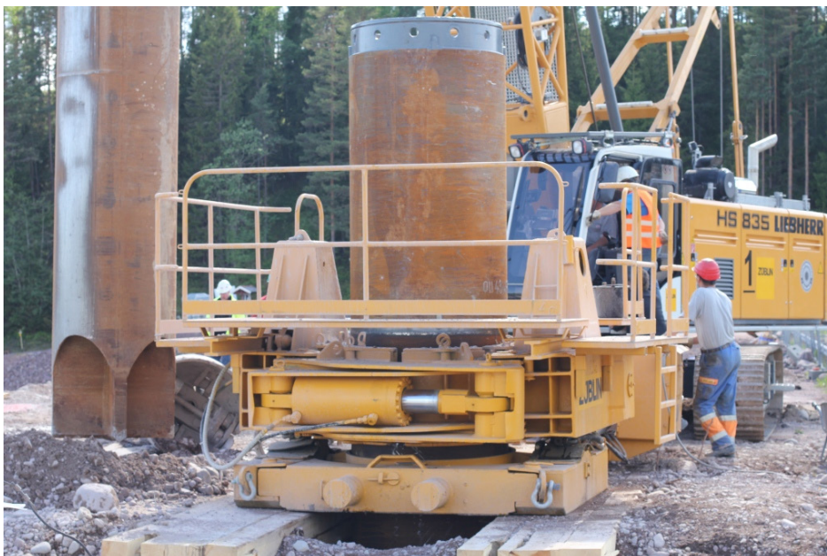
Figur 6.6 - 3 Foderrör under neddrivning. Oscillatoren vilar på träbjälkar för att inte skada de gjutna styrbalkarna. Till vänster syns mejseln som lyfts.
