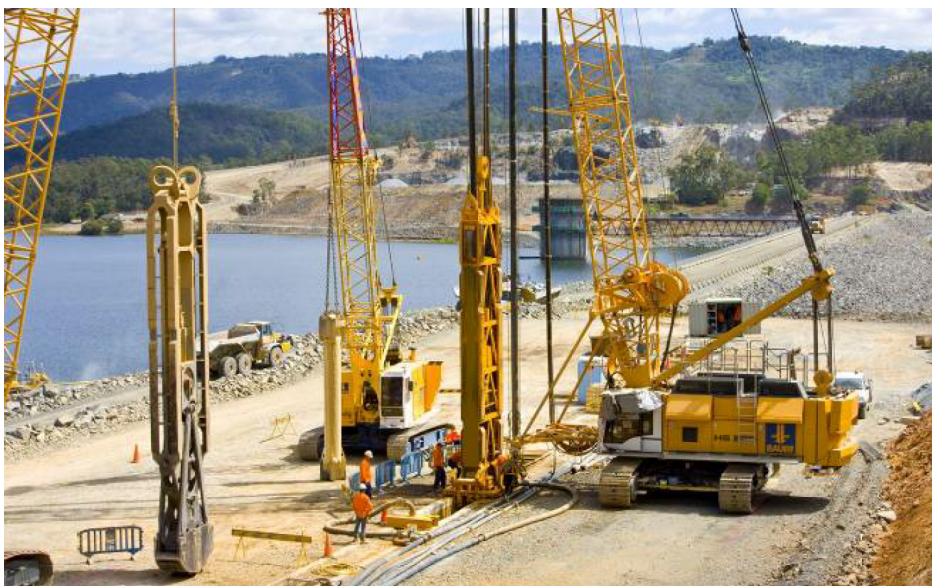
Figur 4.4 – 1 Maskinuppställning. Gripskopa (Clamshell), hydraulisk slits fräs (Hydrofrace) samt en mejsel (chisel) i bakgrunden, se referens [4.4 – 2]].
