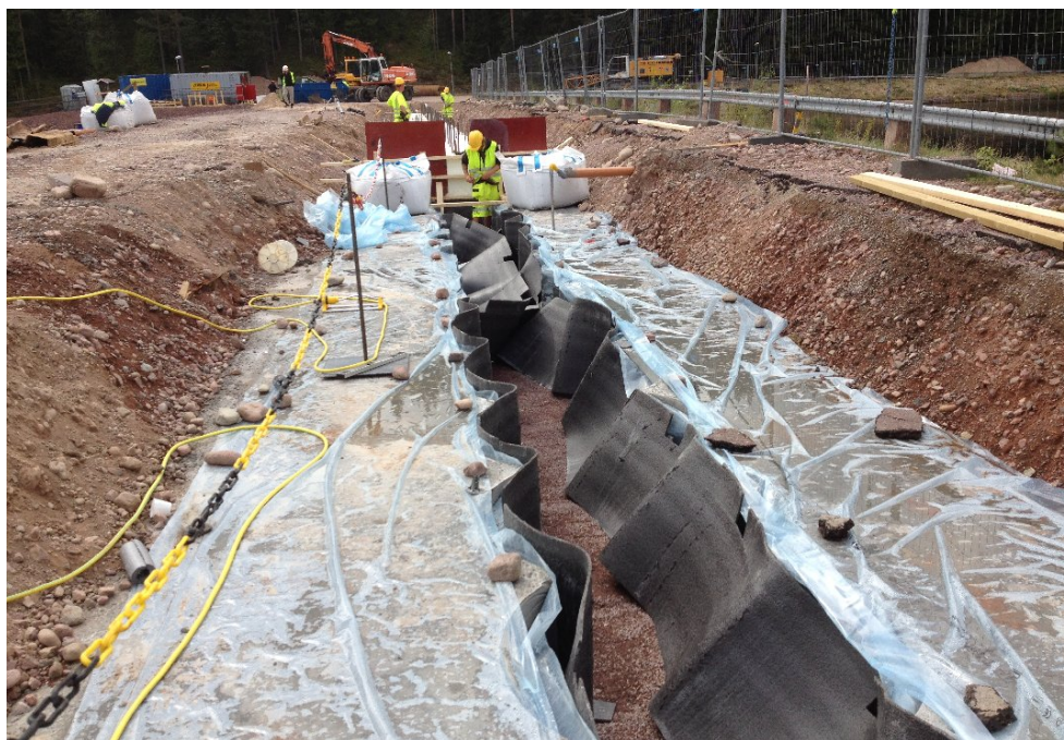
Figur 6.6 - 1 Första etappen styrbalkar gjutna och frigolitblocken borttagna.
