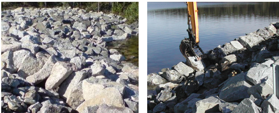
Figur 2.2 – 2 Exempel på ordnat erosionsskydd med god kontakt mellan blocken och även blocken orienterade med längdaxeln vinkelrätt mot slänten. Utläggningen görs med fördel med gripskopa för att kunna placera blocken individuellt så att de låser varandra på ett fullgott sätt.
