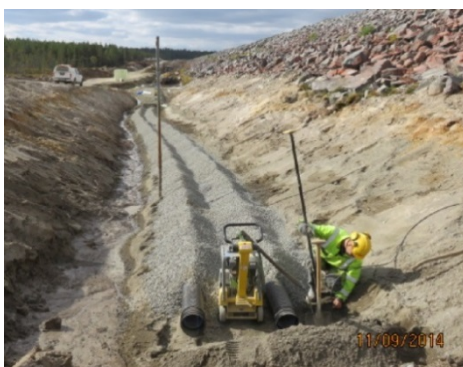
Figur 2.3 – 2 Exempel på arrangemang för dränering längs dammtån.
