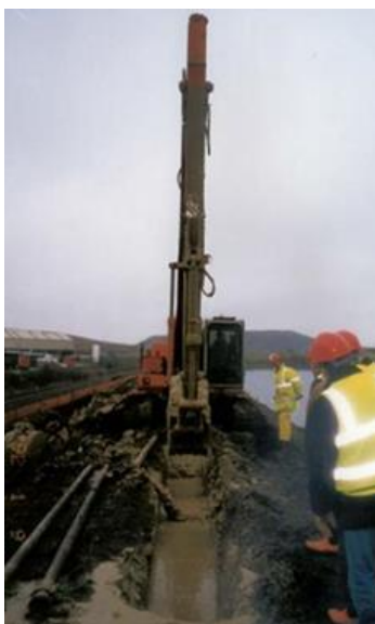
Figur 4.2 – 5 Juktan – Schakt av slits fylld med cement/bentonit-slurry och färdig 'slurry wall' med stålspons.
