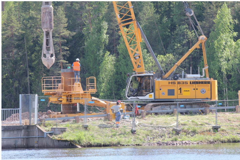
Figur 6.6 - 2 Gripskopa lyfts. Till vänster syns material som tagits upp ur foderröret med gripskopa.
