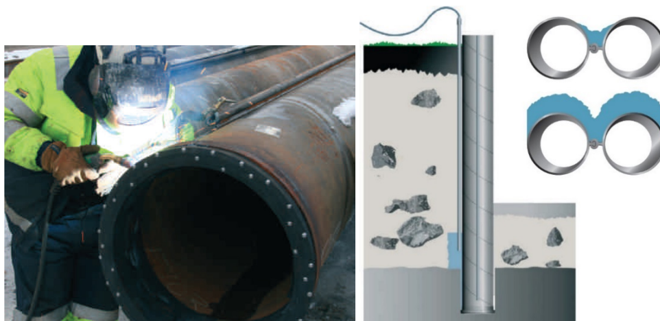
Figur 3.4 - 6 Montering av ringborrkrona och förbättring av låsens vattentätthet genom injektering.
