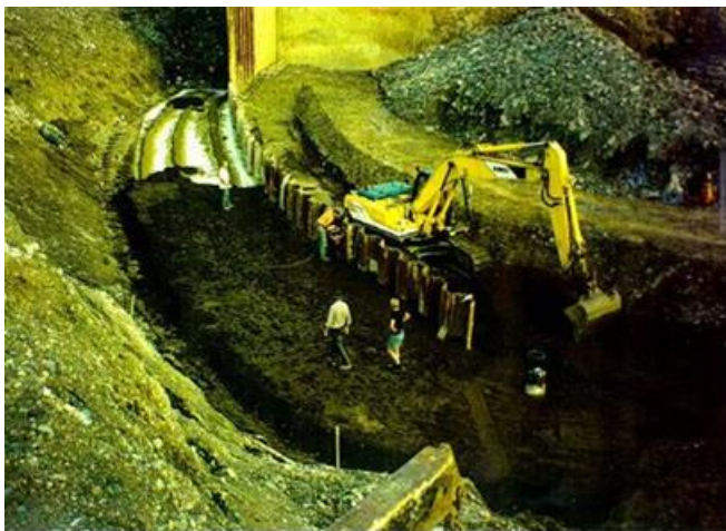
Figur 4.3 – 5 Lövön, slurry wall och montering av spons är färdigställd och uppbyggnad av traditionell dammkropp påbörjad.
