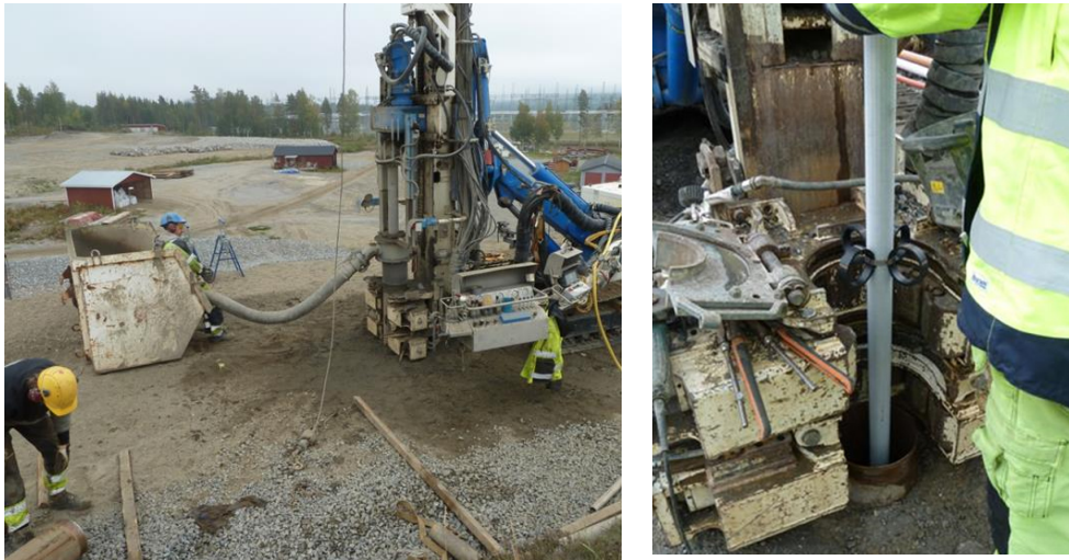
Figur 8.6 - 2 Installation av vertikala dräner(vänster) och centrering av silrör (höger).
