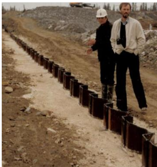
Figur 4.2 – 5 Juktan – Schakt av slits fylld med cement/bentonit-slurry och färdig 'slurry wall' med stålspons.
