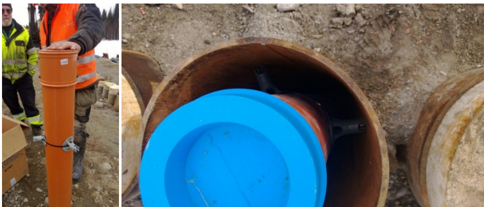
Figur 5.5 - 7 Foderrör med monterade distanser och placering i rörpålarna.
