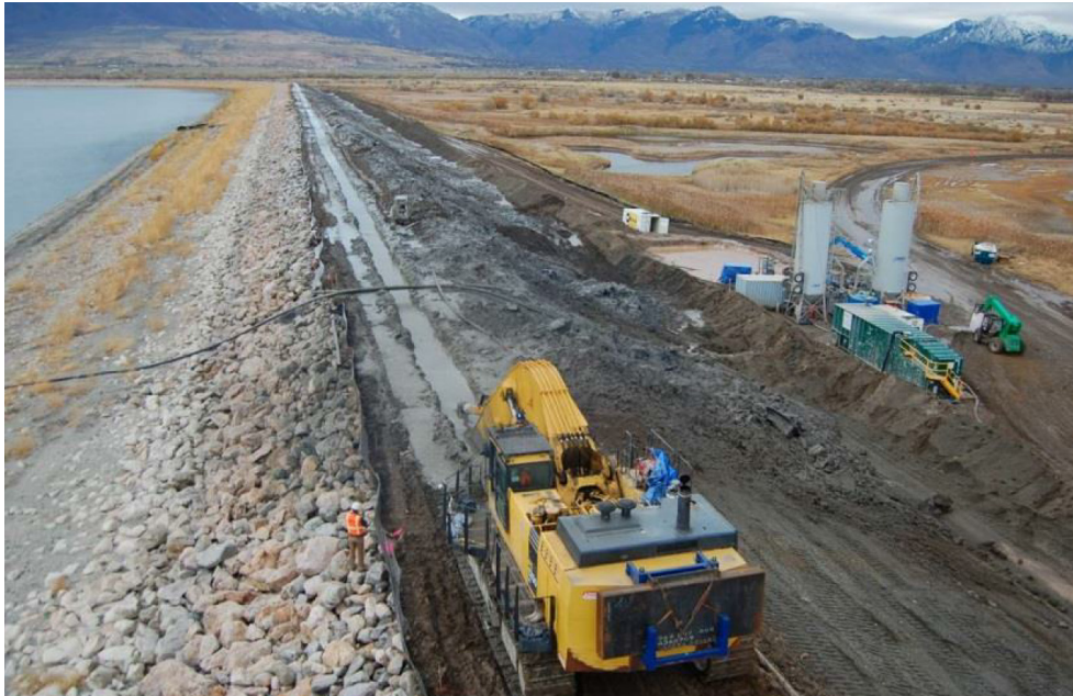
Figur 3.2 – 1 Kontinuerlig schakt av en Jord-Bentonit slitsmur ("Soil-Bentonite, SB slurry wall"), A.V. Watkins Dam, Utah.
