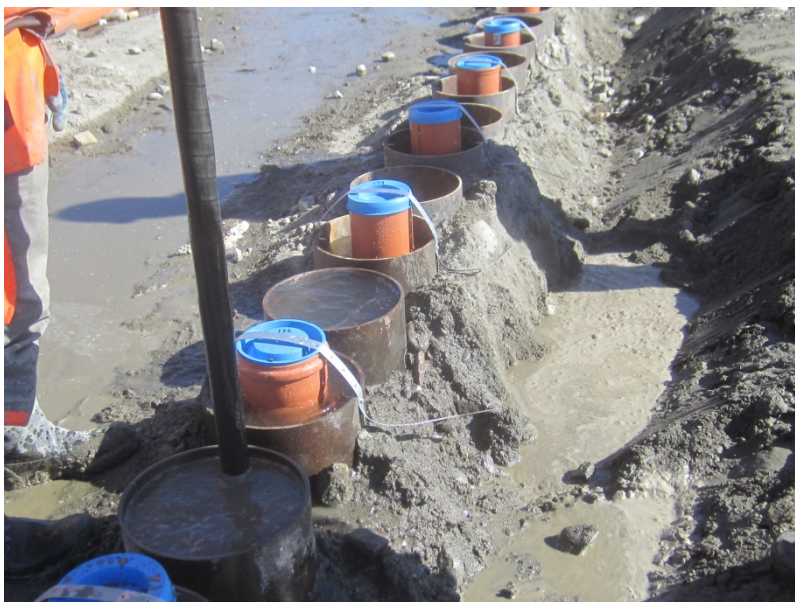
Figur 5.5 - 8 Foderrör monterade i varannan rörpåle.
