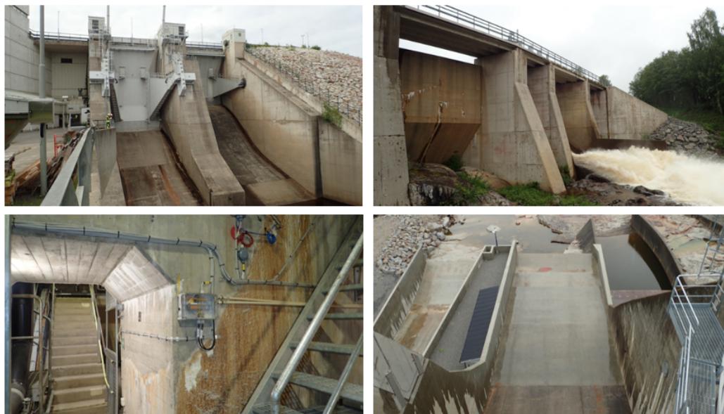
Figur 13. Exempel på grova betongkonstruktioner i vattenkraftsmiljö.
