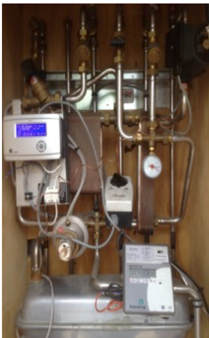
Bild: Undercentraler utrustade med Exigo-DUC och anslutna till teknikplattformen Green IT Homes
