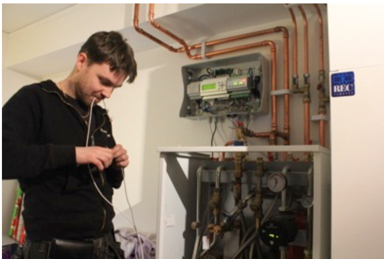
Installation av Corrigo-DUC. Installationen sker i separat apparatskåp.
