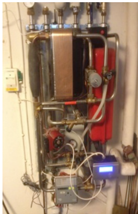
Bild: Undercentraler utrustade med Exigo-DUC och anslutna till teknikplattformen Green IT Homes
