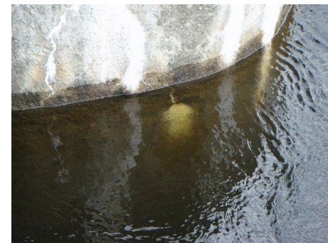
Urlakningsprocessen är sannolikt mest intensiv strax under vattenlinjen.
