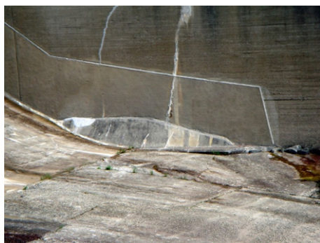
Ledmur vid utskov utsatt för tvång och sprickanvisning.
