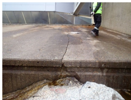
Platta vid utskov utsatt för tvång och sprickanvisning.
