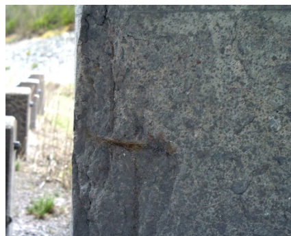
Skadad bropelare orsakad av kloridinitierad armeringskorrosion
