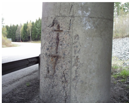
Skadad bropelare orsakad av kloridinitierad armeringskorrosion
