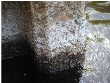
a) Jämn urlakning i kombination med frostangrepp vid vattenlinjen, se även avsnitt Figur 5-2.
