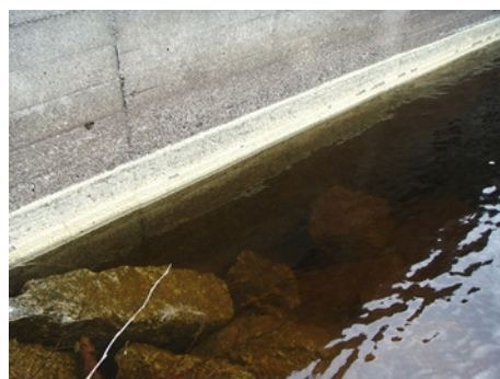
De urlakningsprodukter och skador som syns i bilden är tecken på synergi mellan frostan-grepp och urlakning.
