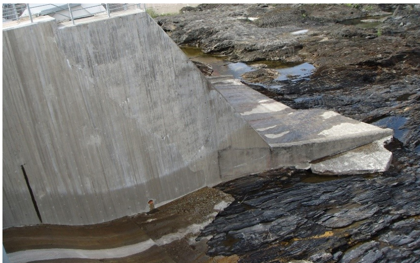
Figur 3-3 Spricktillväxt orsakad av tvång från betongunderlag.
