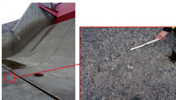
Figur 2-19 Eroderad betongyta
