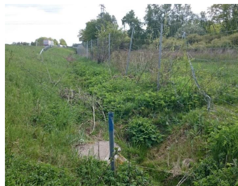
Provpunkt ÅD2, dagvatten nedströms ÅVC (utlopp betongbrunn)
