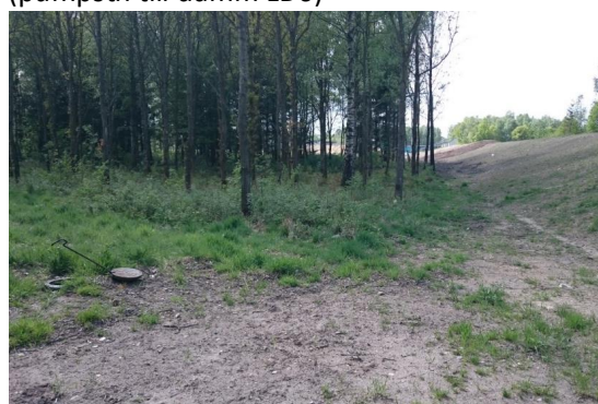
Provpunkt ÅD3, drän vatten från ÅVC-området (spolbrunn på dräneringsledning)
