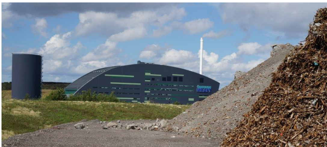
Bild 1. Bottenaskan, ca 35 000 ton/år kommer från förbränning av ca 160 000 ton avfall och 40 000 ton skogsbränsle per år i KVV Filborna, Helsingborg
