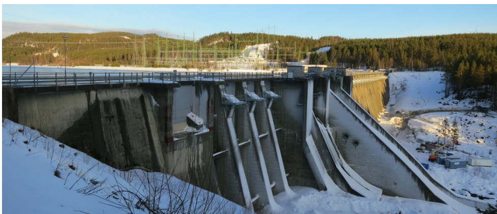
Figur 1. Ramsele kraftverk, inklusive betongdammen, uppfördes 1954–1958.
