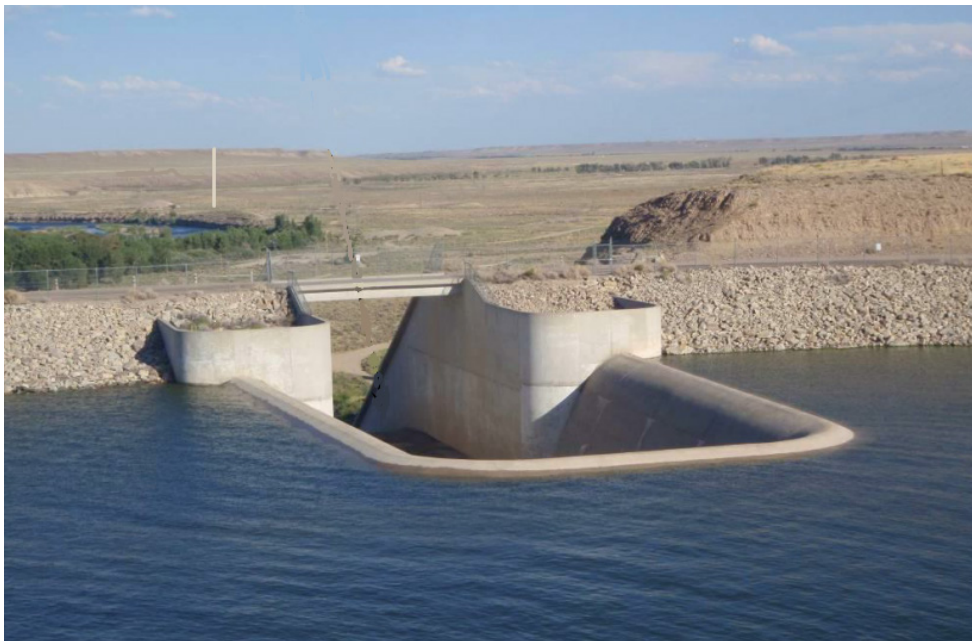
Figur 10 Exempel på ett U-format sidokanalsutskov. [1]
