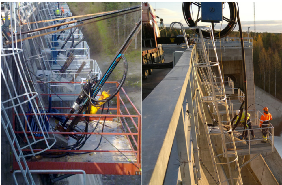
Figur 2.3. Installation av spännstag i befintlig konstruktion. Borrhning av hål för foderrör (vänster), installation av foderrör (höger). Foto från Uniper.
