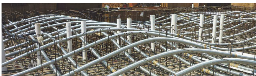
Figur 1.1. Foderrör installerade före betongen gjuts, bild från BBR produktblad.
